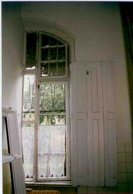
33 - BUDYNEK MOPS-u OKNO W PIĄTEJ OŚI FASADY PIERWSZEJ KONDYGNACJI (WTÓRNICIE PRZEDZIELONE)
