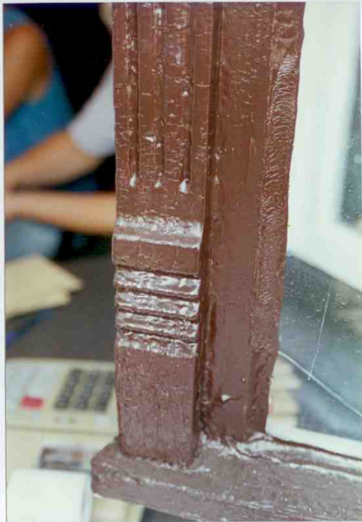
32 - BUDYNEK MOPS-u FRAGMENT STOLARKI OKIENNEJ BUDYNKU ŁĄCZNIKOWEGO
