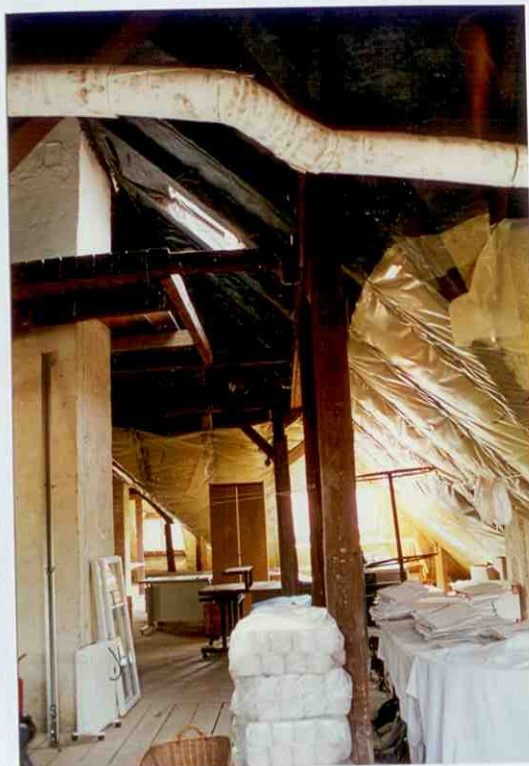
24 - BUDYNEK MOPS-u - WIĘŻBA DACHOWA
