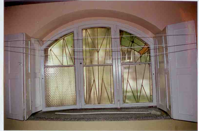
34 - BUDYNEK MOPS-u OKNO DAWNEGO HOLU Z ZACHOWANYM FRAGMENTEM OSZKLENIA WITRAŻOWEGO (DRUGA OŚ PIERWSZEJ KONDYGNACJI ELEWACJI TYLNEJ)
