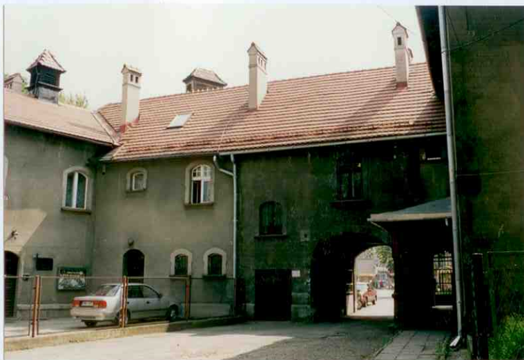
11 - ELEWACJA TYLNA (PÓLNOCNO-ZACHODNIA) BUDYNKU ŁĄCZNIKOWEGO
