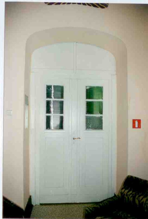
42 - BUDYNEK MOPS-u DRZWI Z KORYTARZA DO HOLU NA PARTERZE
