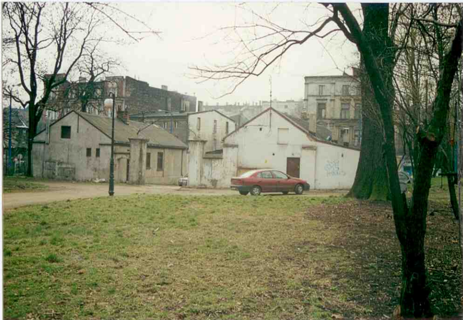
BUDYNKI BRAMNE – WIDOK OD STRONY PARKU
