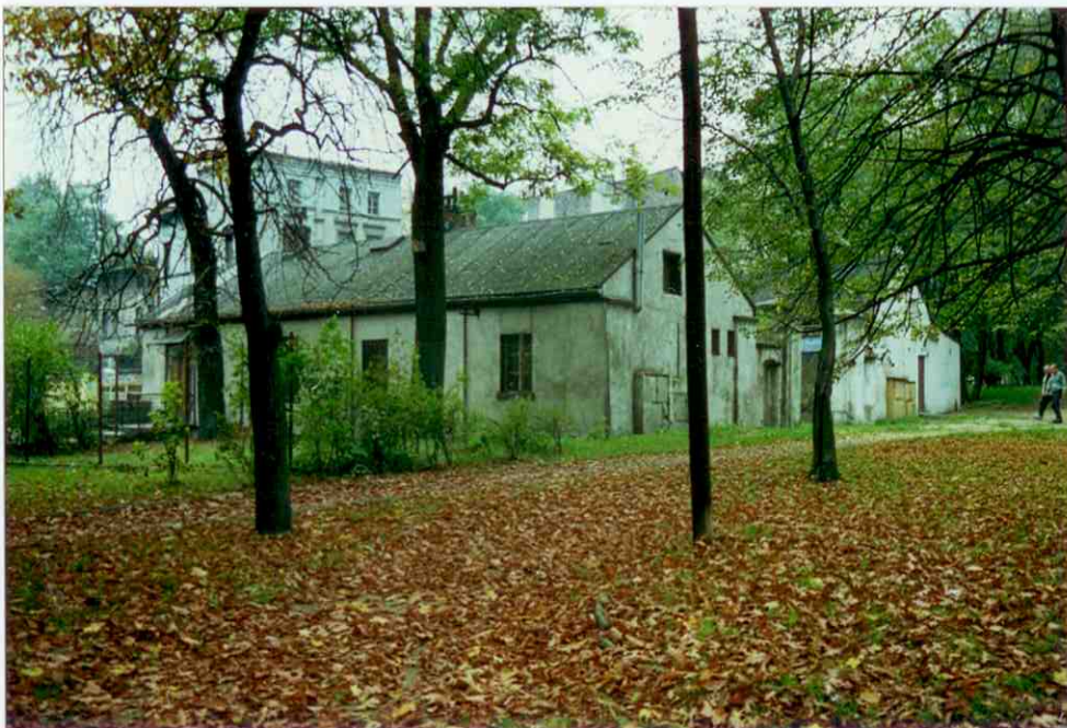
BUDYNKI BRAMNE – WIDOK OD STRONY PARKU
