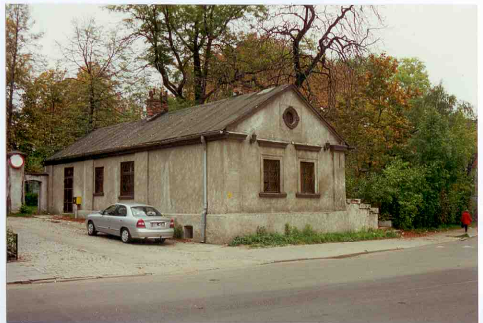
BUDYNEK BRAMNY NR 18A
