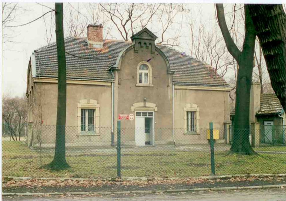
1. Elewacja południowo-zachodnia (frontowa).
