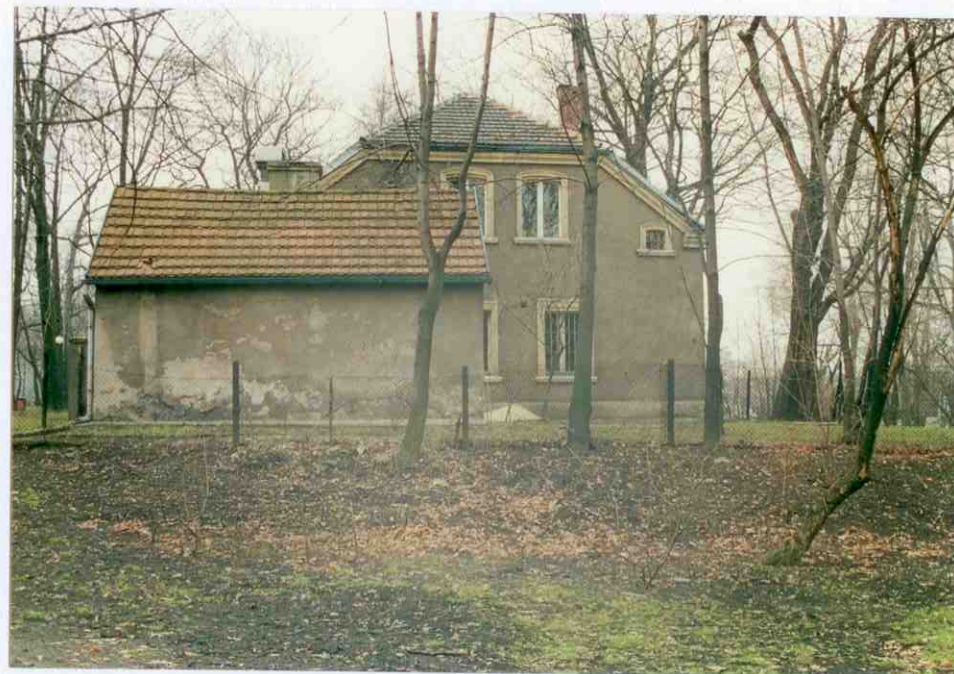
7. Widok ogólny na elewację południowo-wschodnią.
