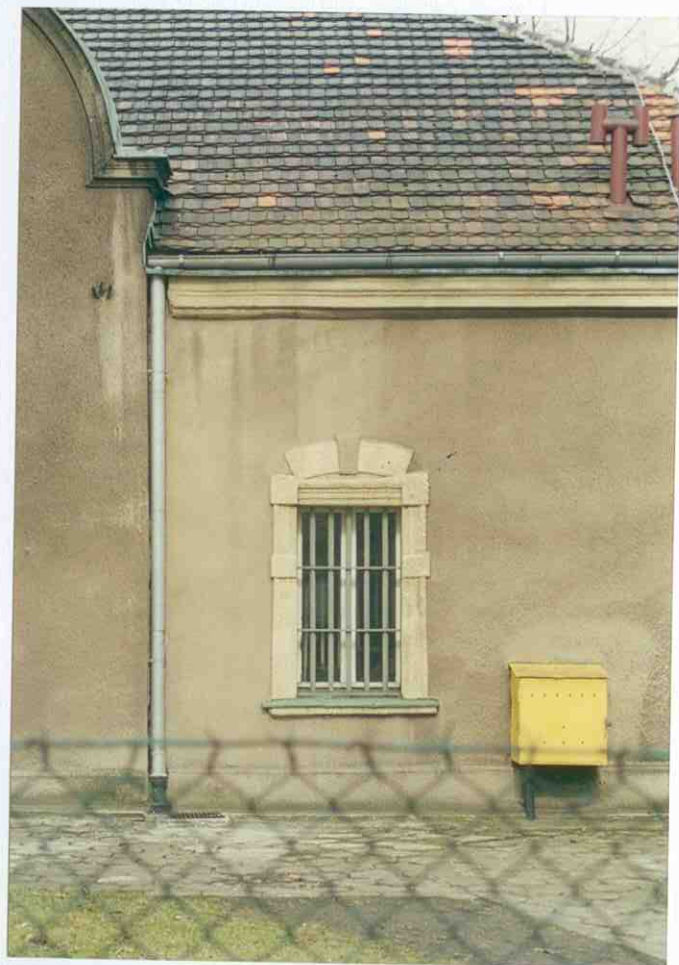
3. Okno. Fragment elewacji południowo-zachodniej (frontowej).
