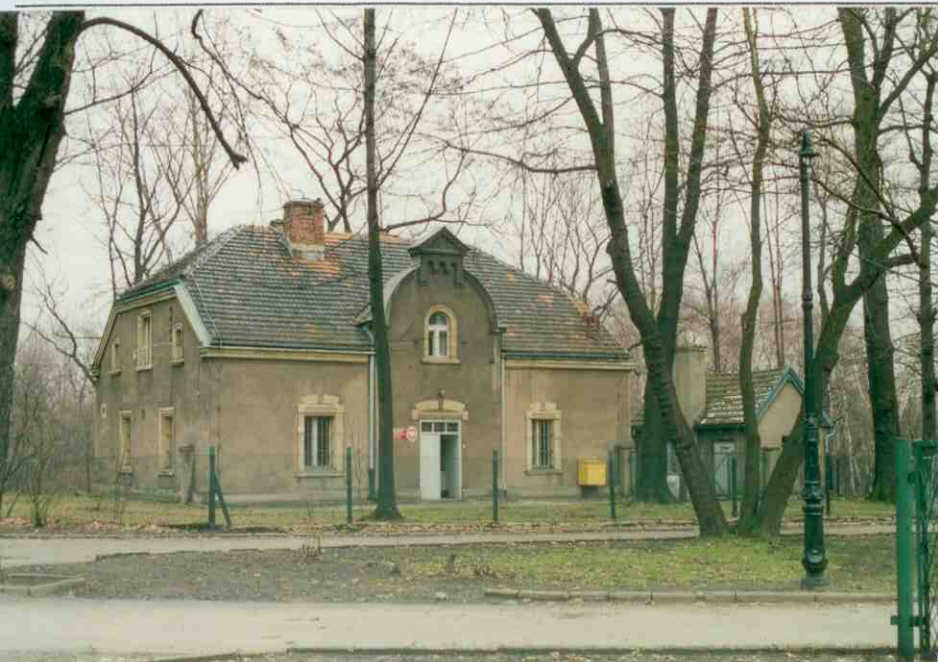
Elewacja południowo-zachodnia (frontowa).
