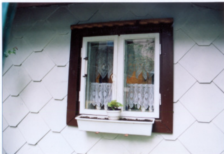
OKNO W ELEWACJI ZACHODNIEJ
