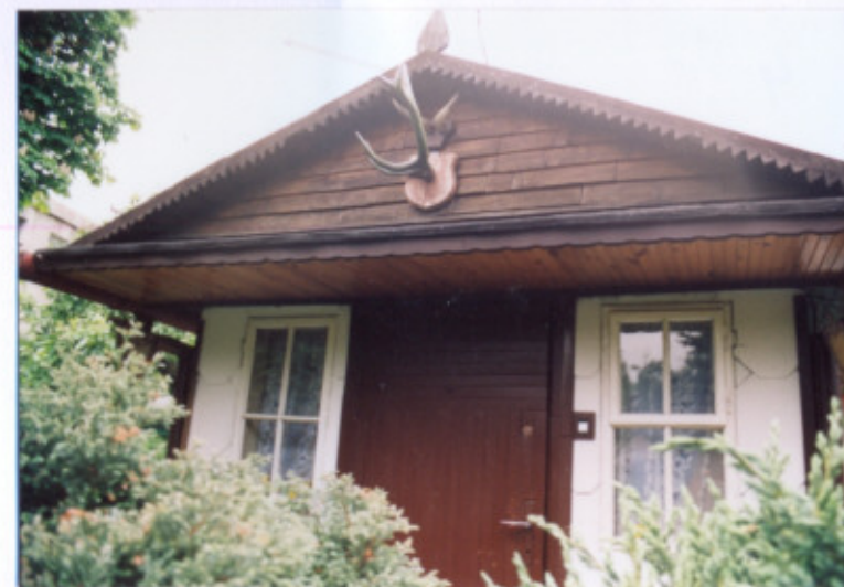
SZCZYT DOBUDÓWKI I WEJŚCIE DO BUDYNKU
