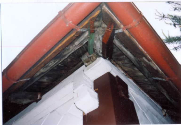
FRAGMENT ELEWACJI Z OKAPEM DACHU
