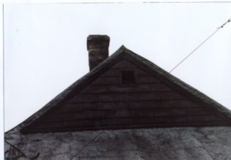
SZCZYT ELEWACJI ZACHODNIEJ
