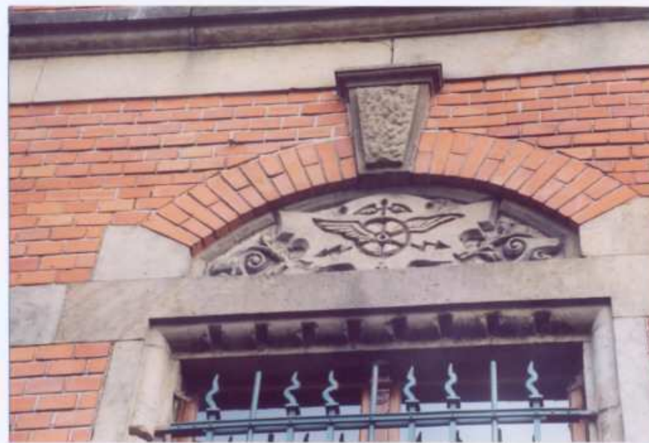
12. Frag. elewacji zachodniej. Detal.
