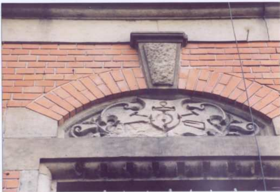
11. Frag. elewacji zachodniej. Detal.
