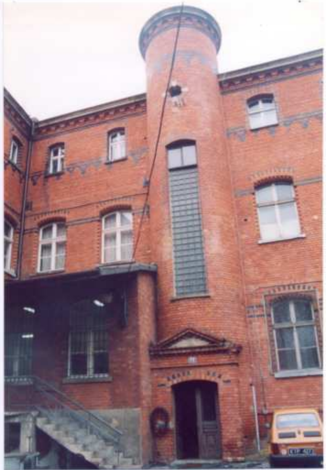
19. Skrzydło budynku. Frag. elewacji południowej.
