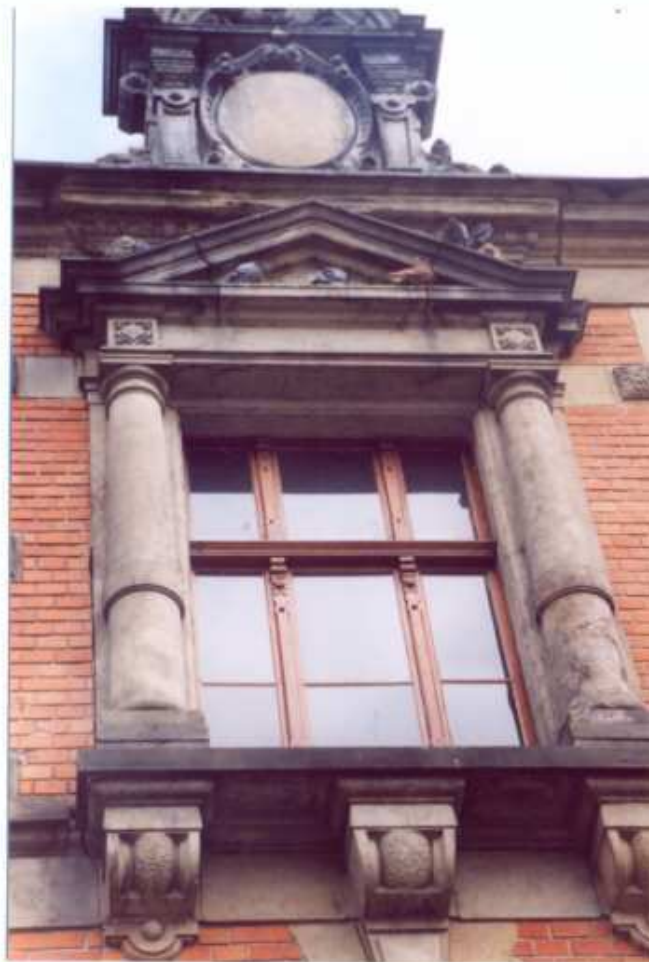
9. Frag. elewacji zachodniej. Detal.
