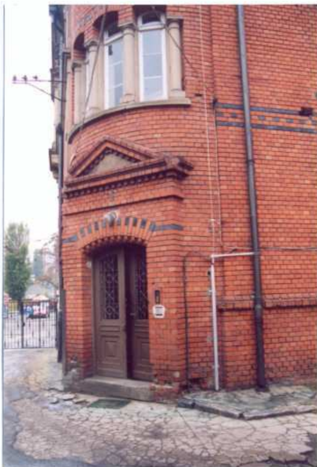
22. Frag. elewacji wschodniej. Drzwi.
