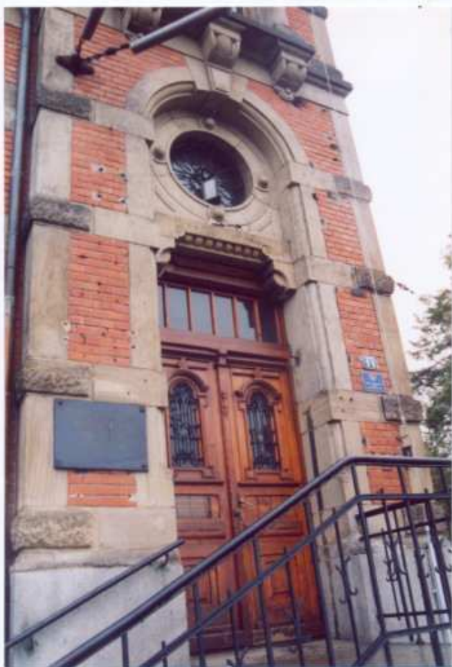
6. Frag. elewacji zachodniej. Drzwi.
