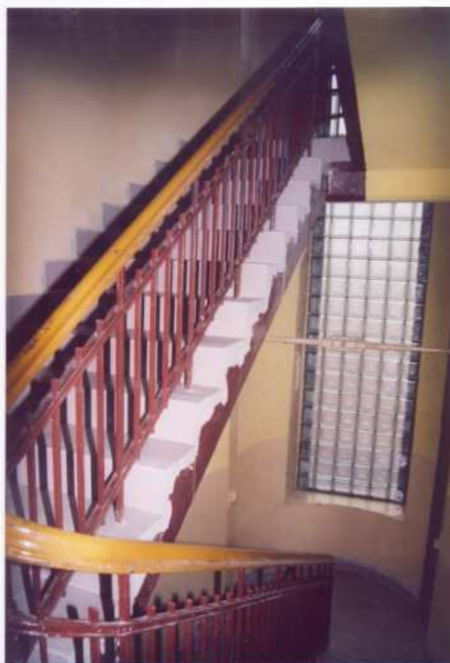
40. Skrzydło budynku. Klatka schodowa.
