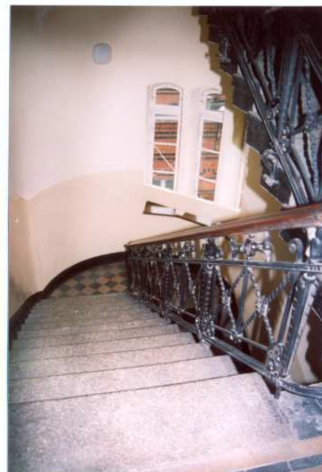
38. Budynek główny. Klatka schodowa.
