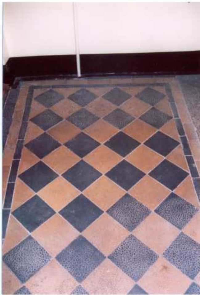
51. Budynek główny. Klatka schodowa. Posadzka.
