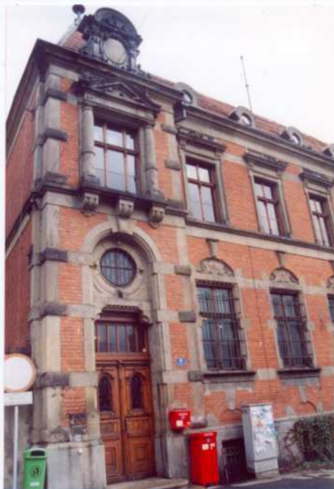
5. Frag. elewacji zachodniej (frontowej).
