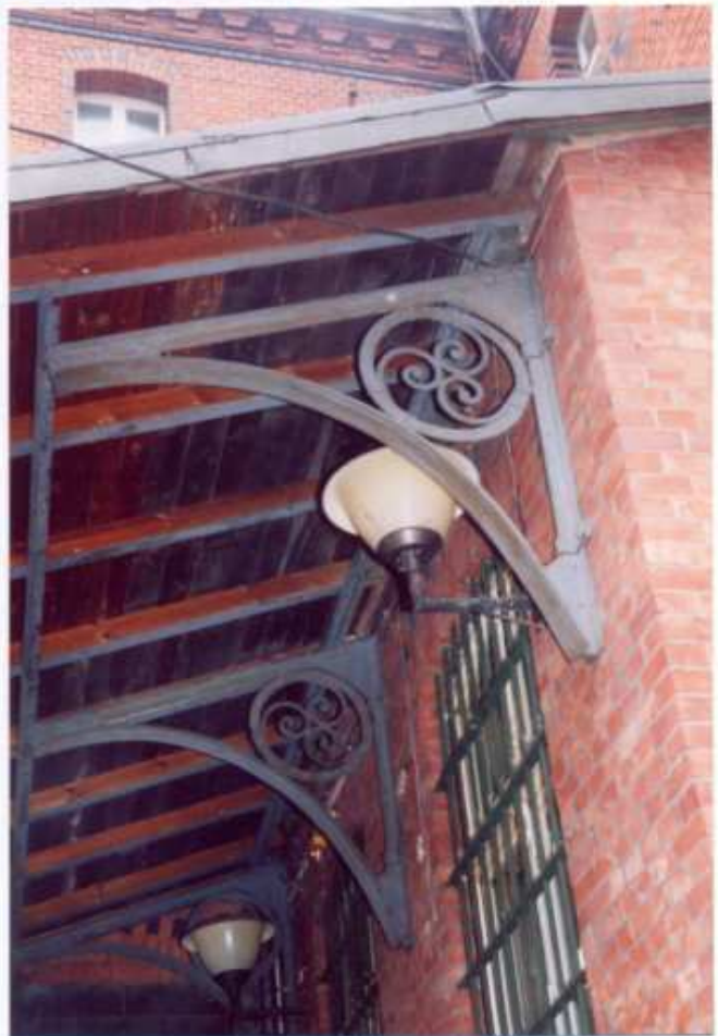
21. Skrzydło budynku. Frag. elewacji południowej. Zadaszenie.
