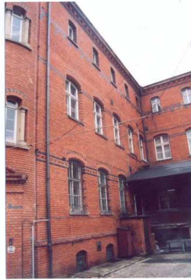
24. Frag. elewacji wschodniej.
