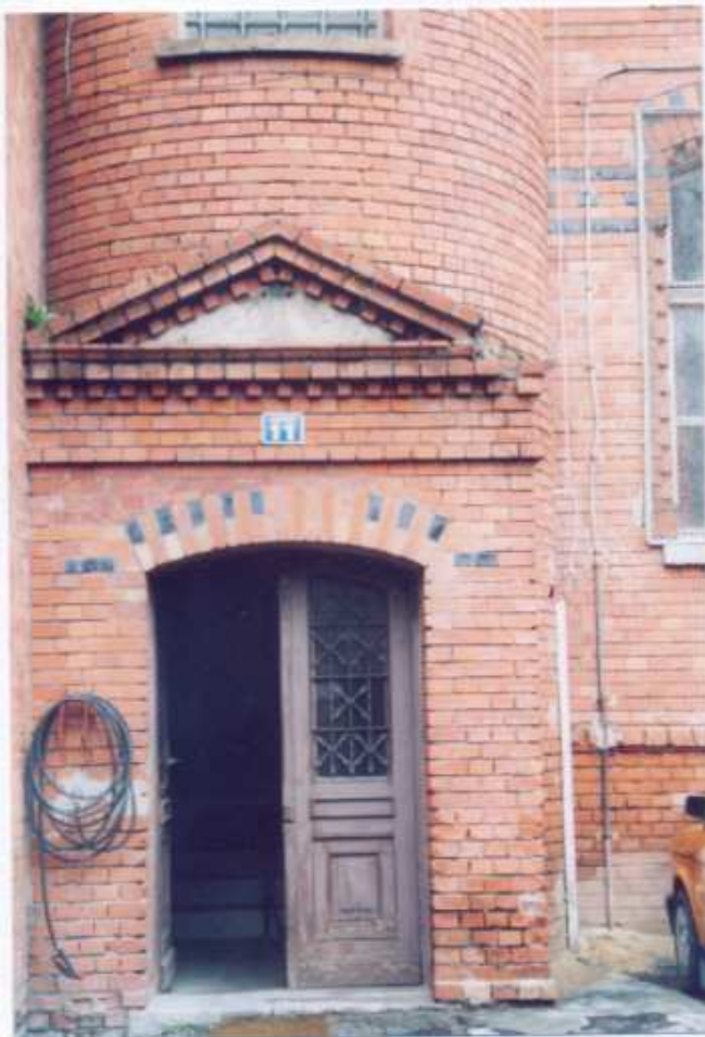
20. Skrzydło budynku. Frag. elewacji południowej. Drzwi.
