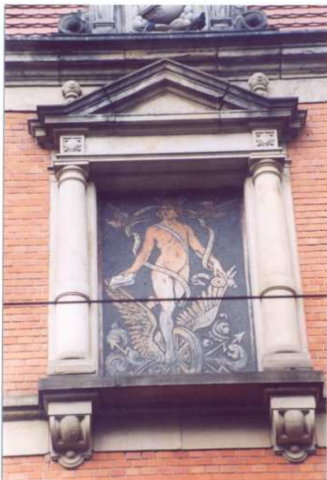
29. Elewacja południowa. Detal.
