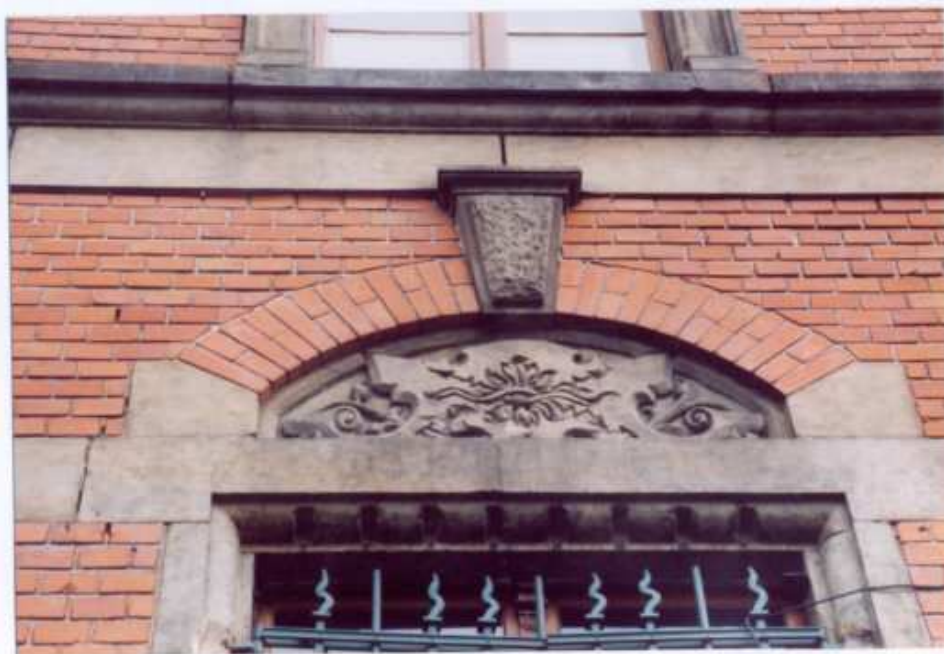
13. Frag. elewacji zachodniej. Detal.
