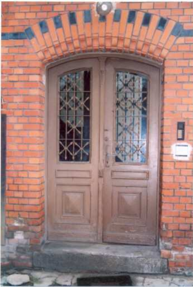
25. Frag. elewacji wschodniej. Drzwi.
