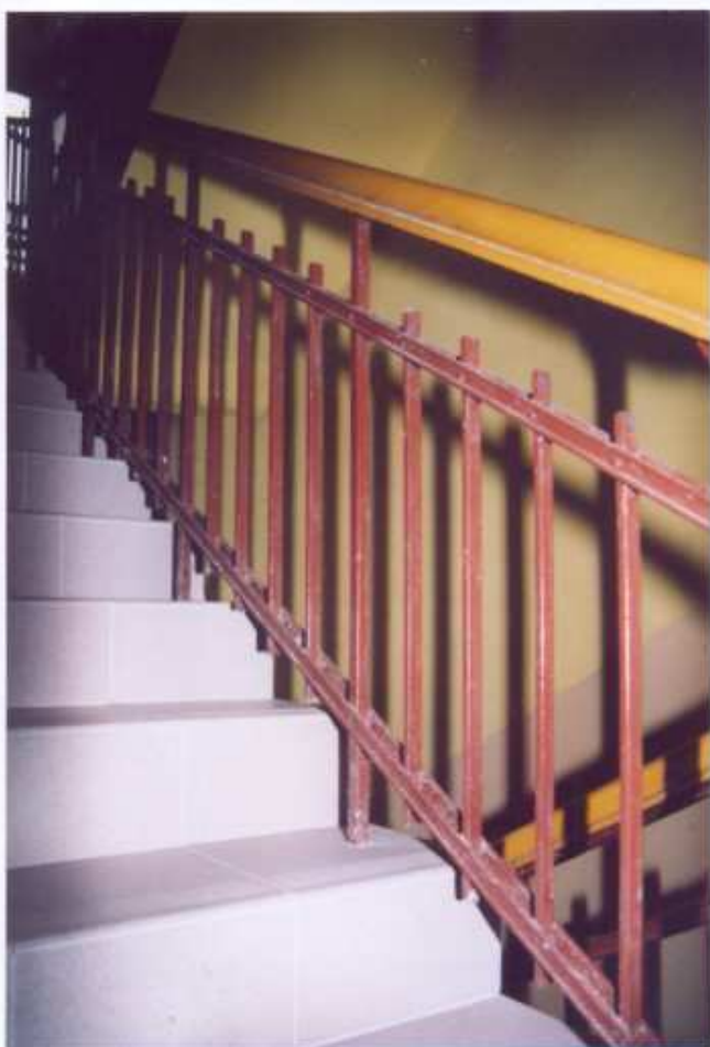
41. Skrzydło budynku. Schody - balustrada.
