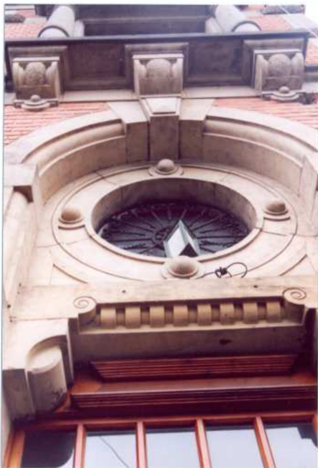
8. Frag. elewacji zachodniej. Detal.
