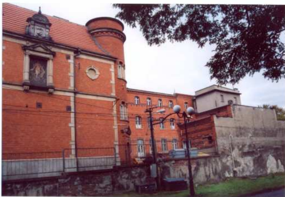
53. Widok ogólny od strony południowo-zachodniej.
