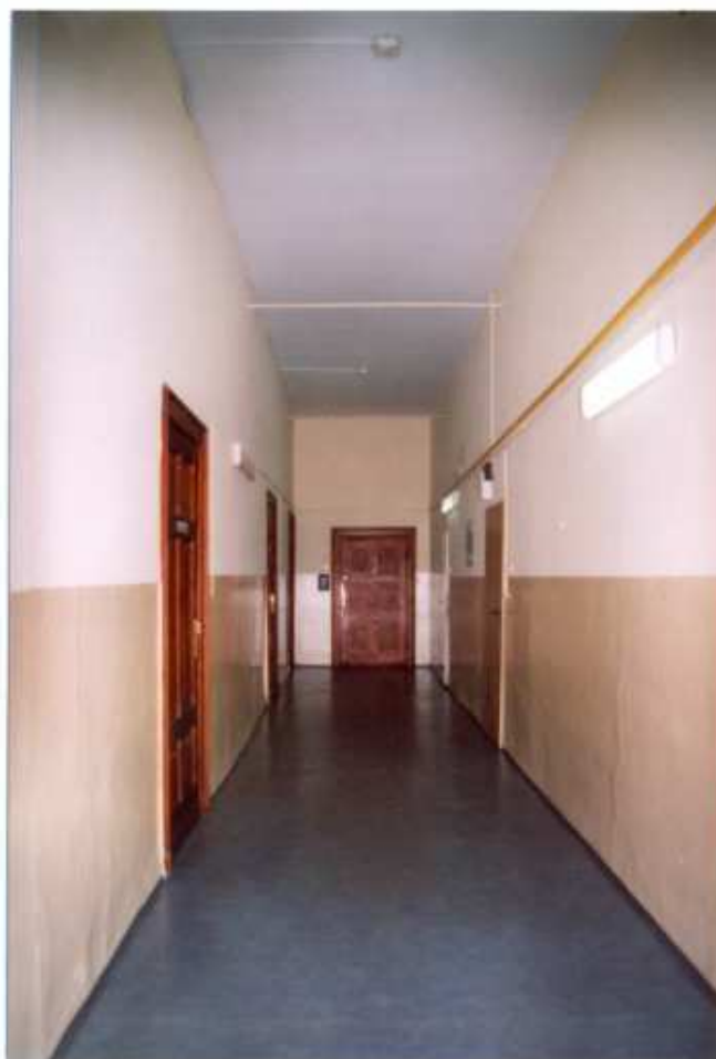
37. Budynek główny. Korytarz.
