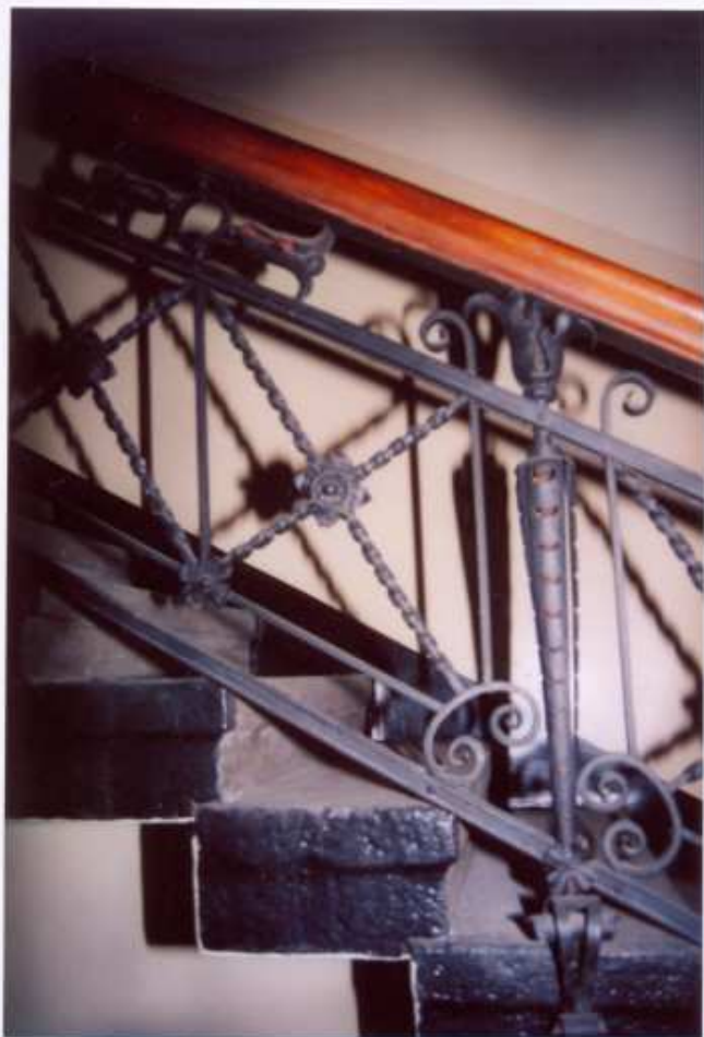
39. Budynek główny. Schody-balustrada.
