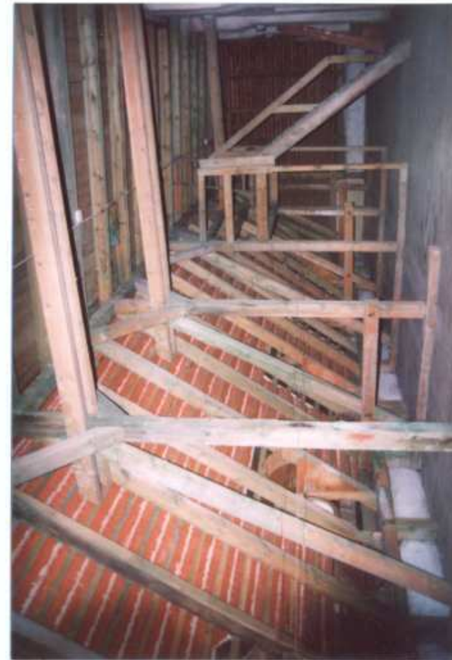
52. Budynek główny. Więźba dachowa.
