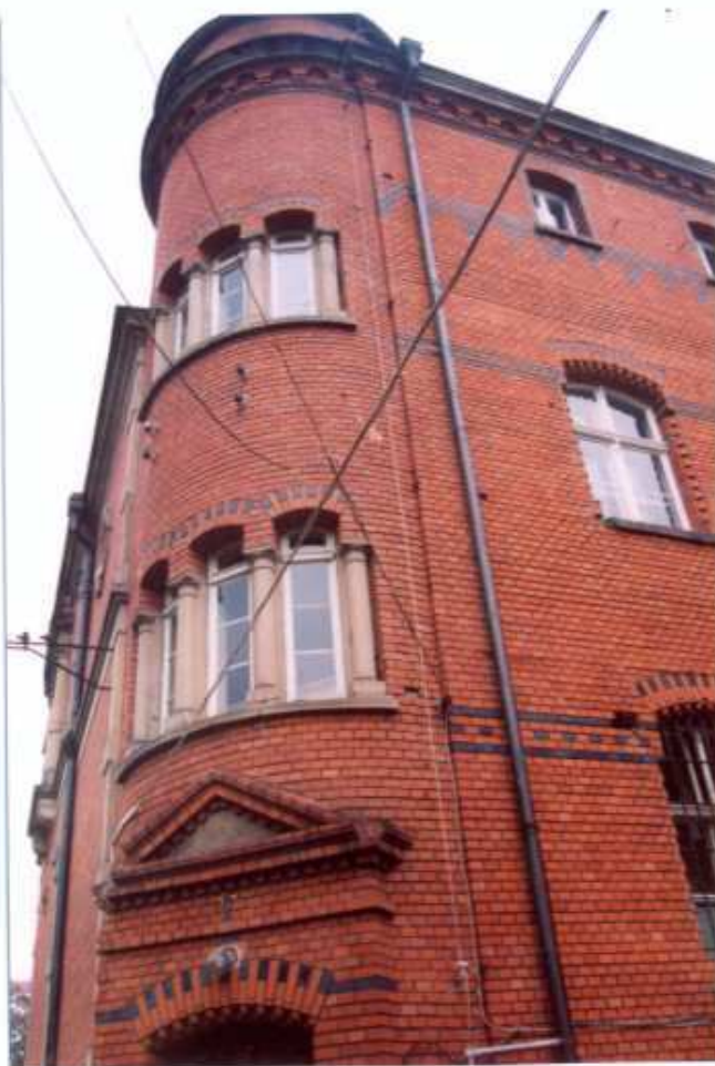
23. Frag. elewacji wschodniej.
