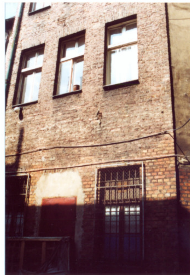
29. Frag. elewacji południowej. Oficyna północna.
