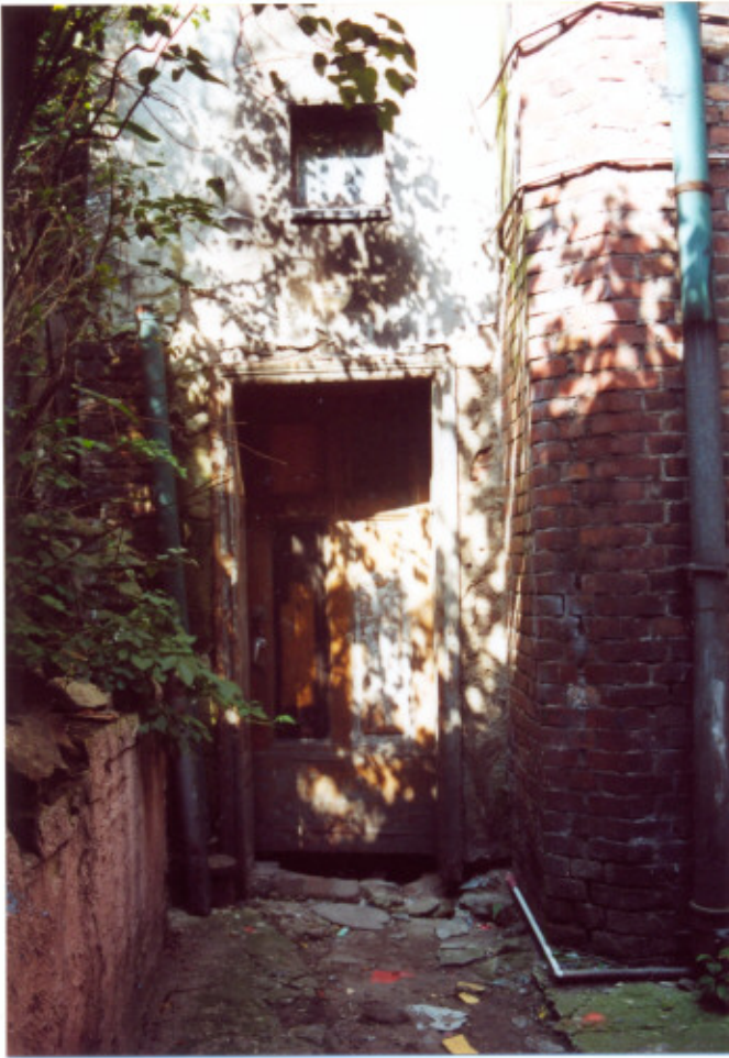
30. Frag. elewacji południowej –oficyna północna. Drzwi.
