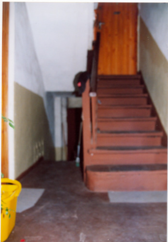
36. Oficyna południowa. Klatka schodowa.
