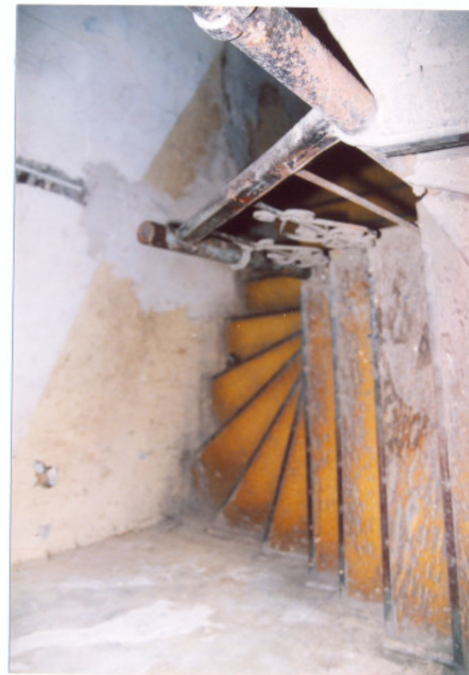
35. Boczna klatka schodowa. Słupek.
