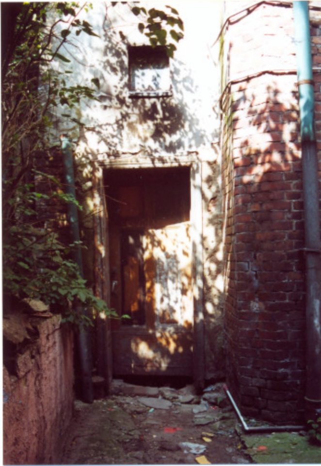
30. Frag. elewacji południowej –oficyna północna. Drzwi.
