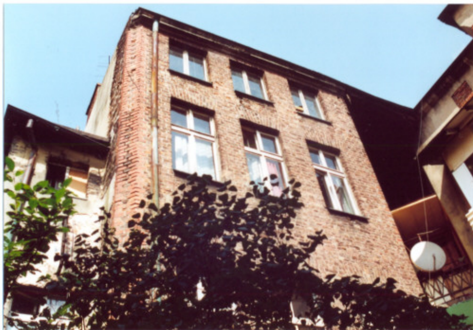
28. Frag. elewacji południowej. Oficyna północna.
