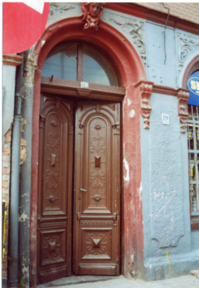
15. Frag. elewacji wschodniej. Drzwi.
