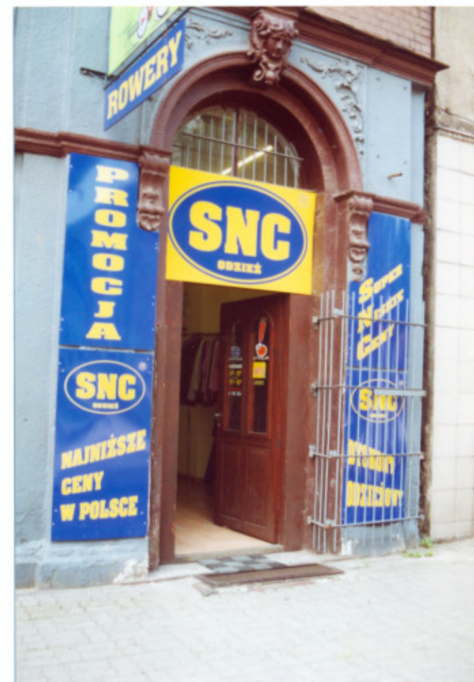
17. Frag. elewacji wschodniej. Drzwi.
