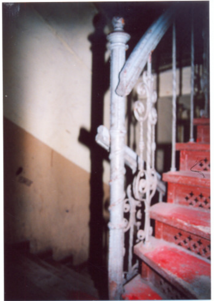
31. Główna klatka schodowa. Słupek.
