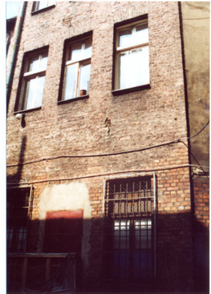
29. Frag. elewacji południowej. Oficyna północna.
