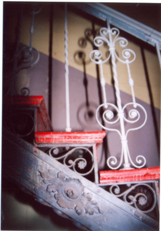
33. Główna klatka schodowa. Balustrada
