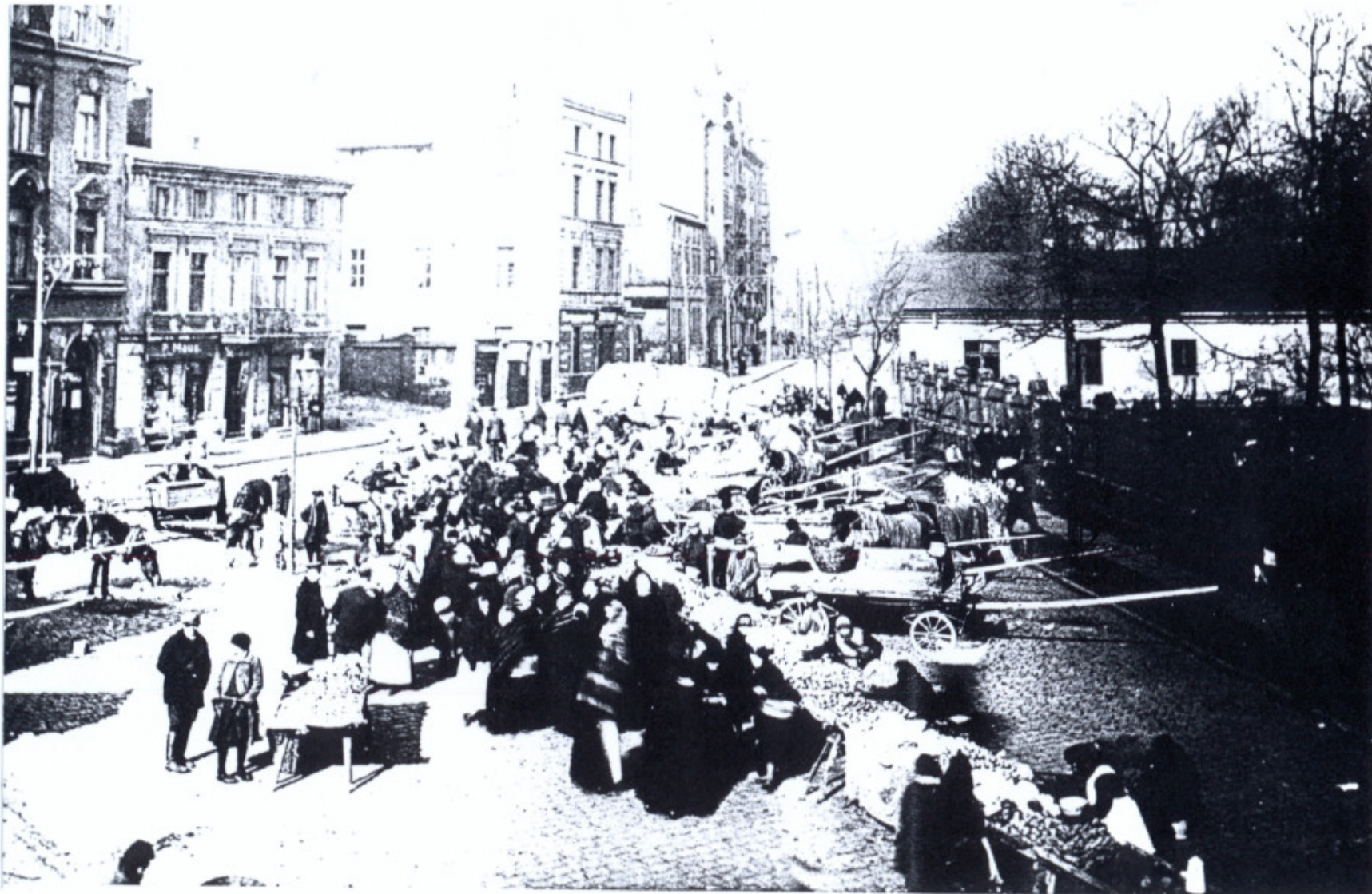
10. Frag. elewacji wschodniej. Archiwalna fotografia z 1 poł. XX wieku.
