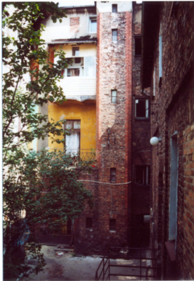
21. Elewacji zachodnia-tylna. Budynek główny.
