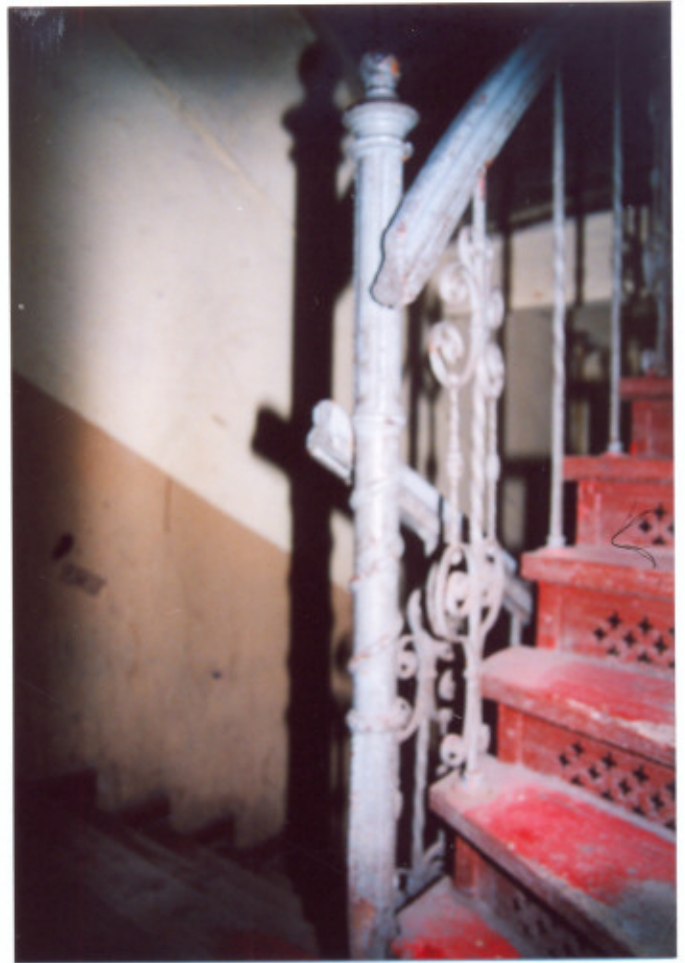
31. Główna klatka schodowa. Słupek.
