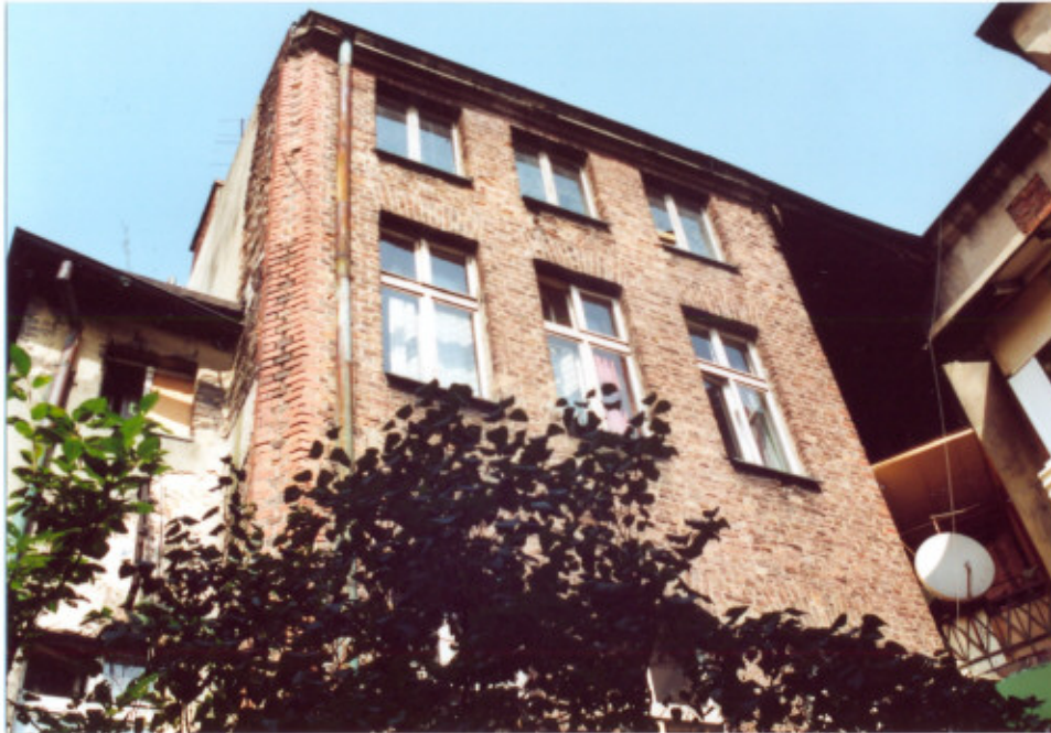
28. Frag. elewacji południowej. Oficyna północna.
