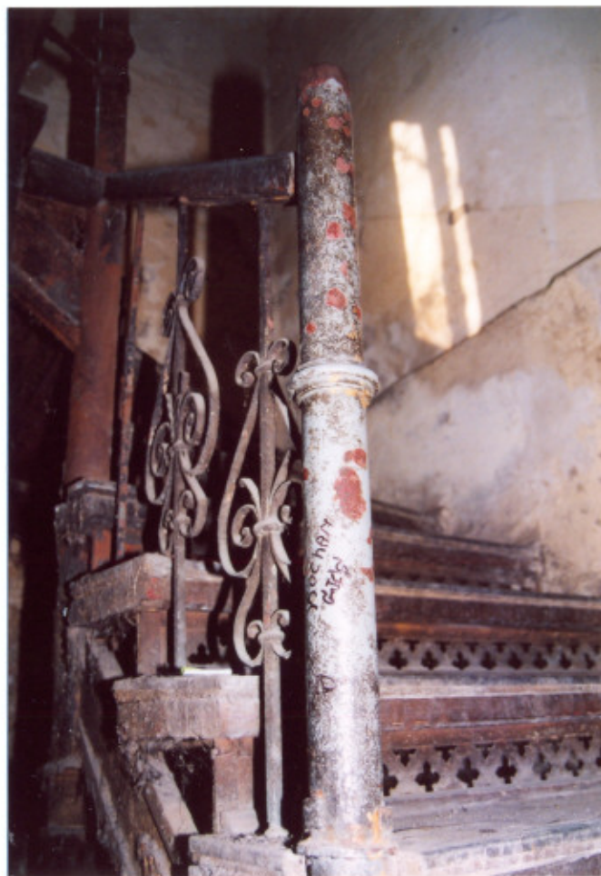
34. Boczna klatka schodowa. Słupek.
