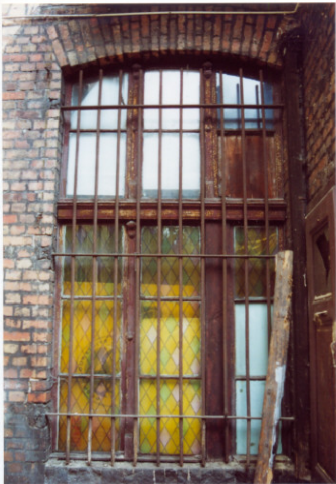
24. Frag. elewacji wschodniej. Okno.
