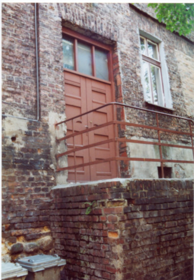
26. Frag. elewacji północnej. Oficyna północna.
