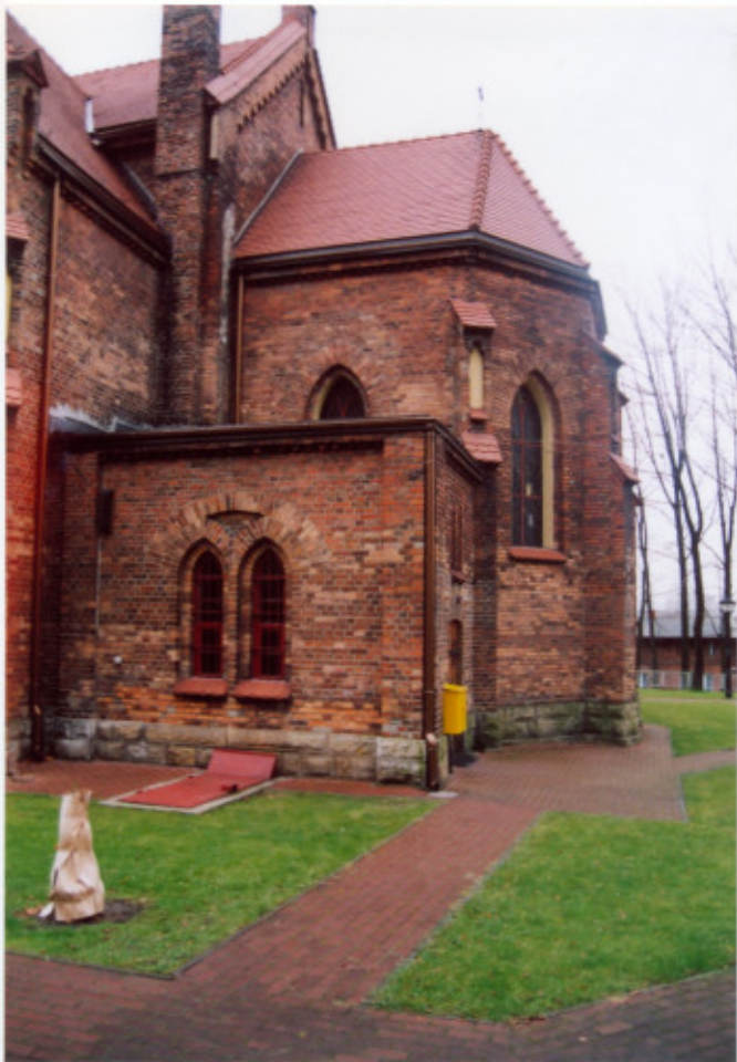
Frag. elewacji południowej. Zakrystia.
