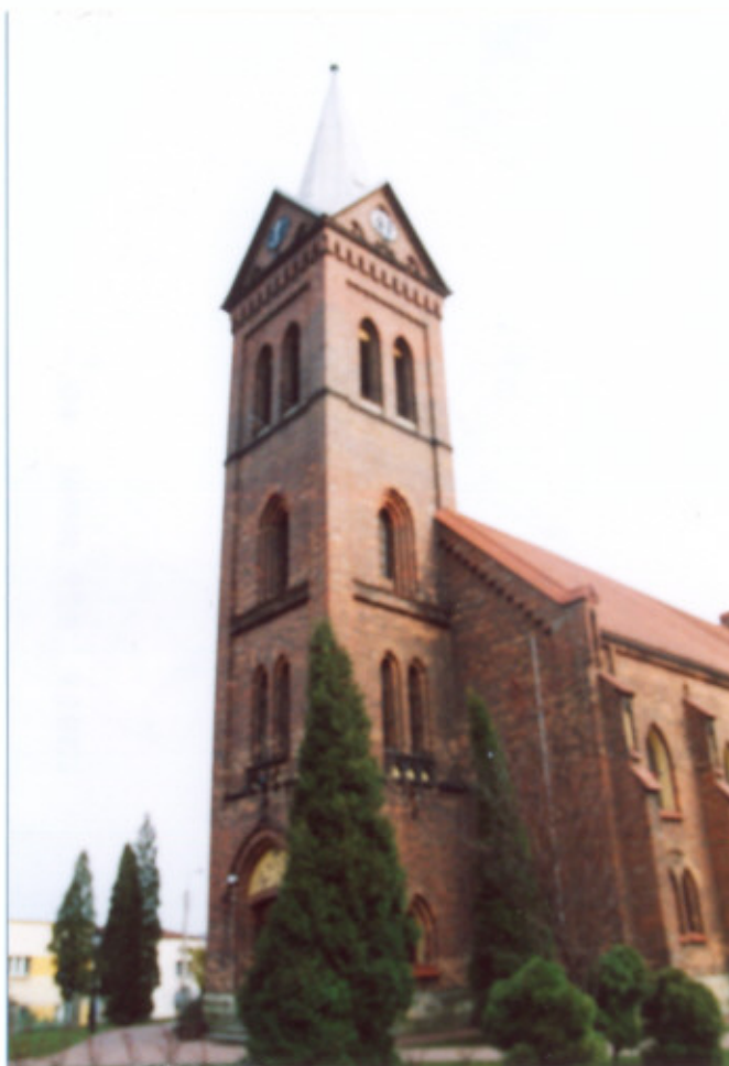
Frag. elewacji południowej. Wieża.
