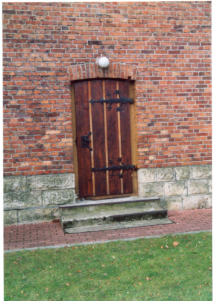
- Frag. elewacji wschodniej. Drzwi.
