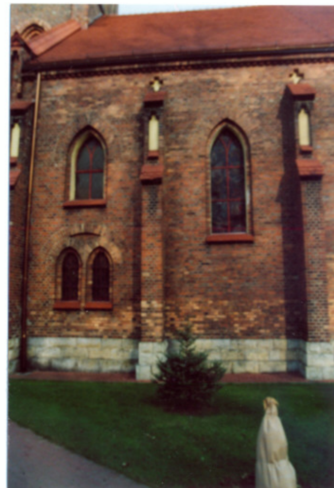
Frag. elewacji południowej. Korpus nawowy.
