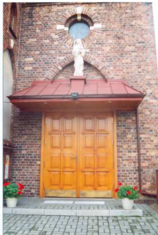
7. Frag. elewacji wschodniej.
