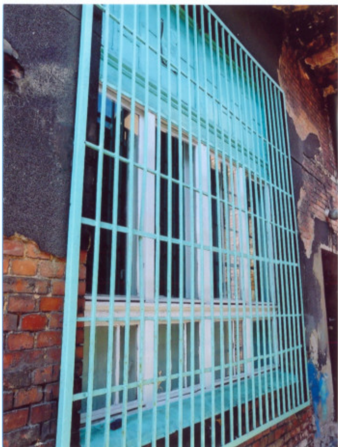
Frag. elewacji wschodniej. Okno.
