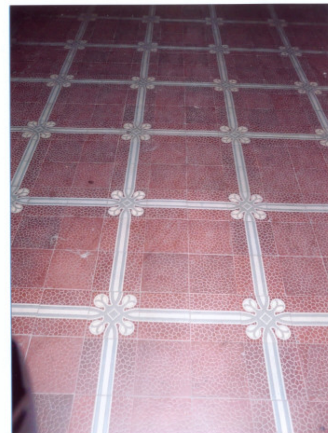
Sień. Frag. wystroju-posadzka.
