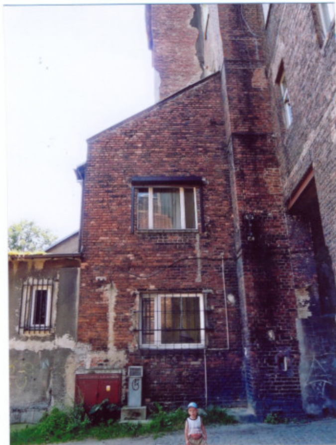
Elewacja północna. Dobudówka.
