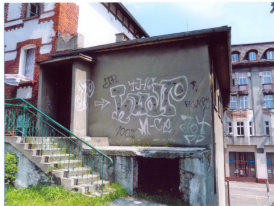
Przewiązka. Elewacja zachodnia.
