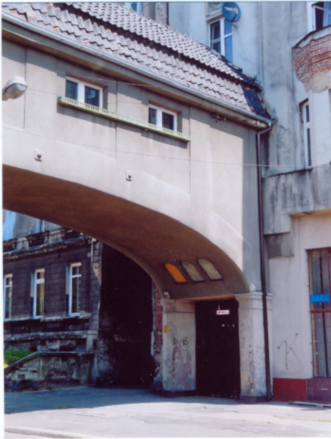
Fraq. elewacji zachodniej.
