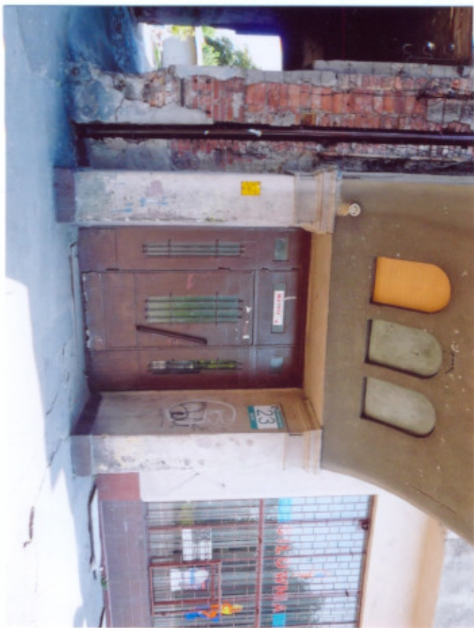
Frag. elewacji zachodniej. Drzwi.
