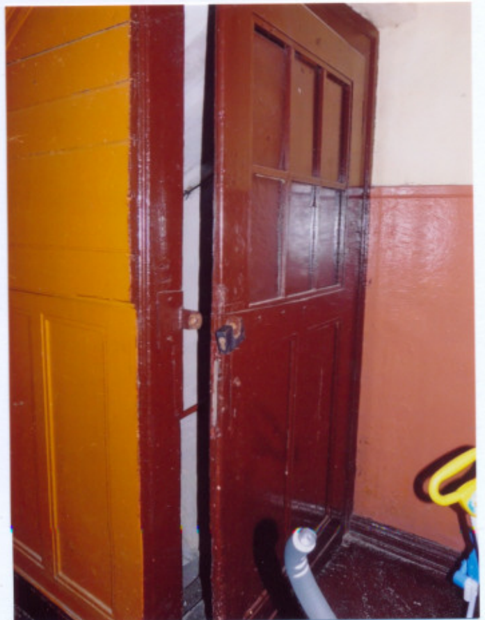
Klatka schodowa. Drzwi-piwnica.
