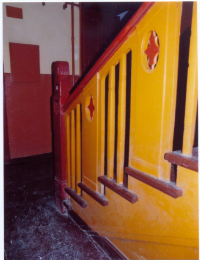
Klatka schodowa. Bariera.
