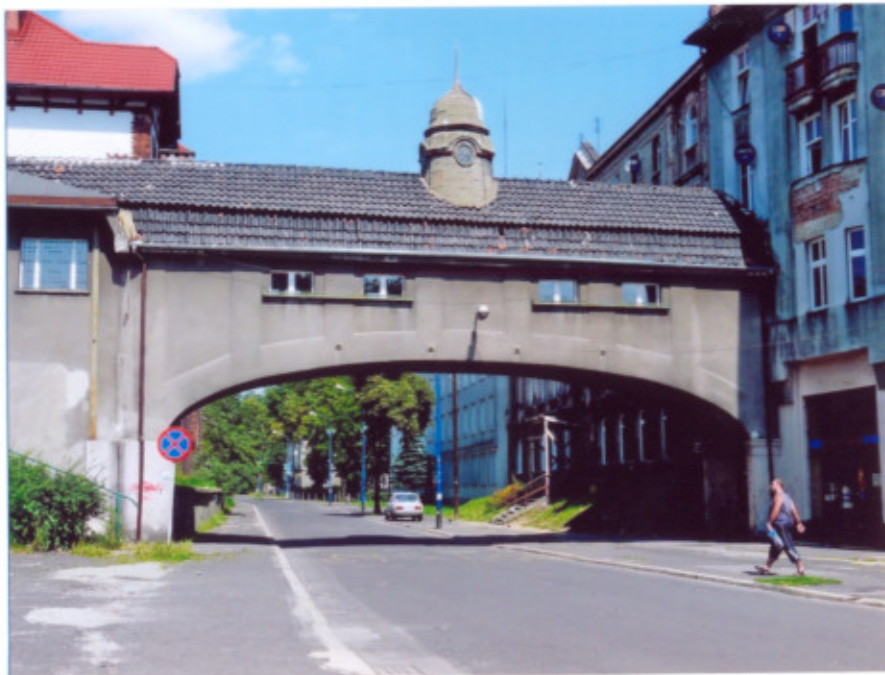
Przewiązka. Frag. elewacji południowej.
