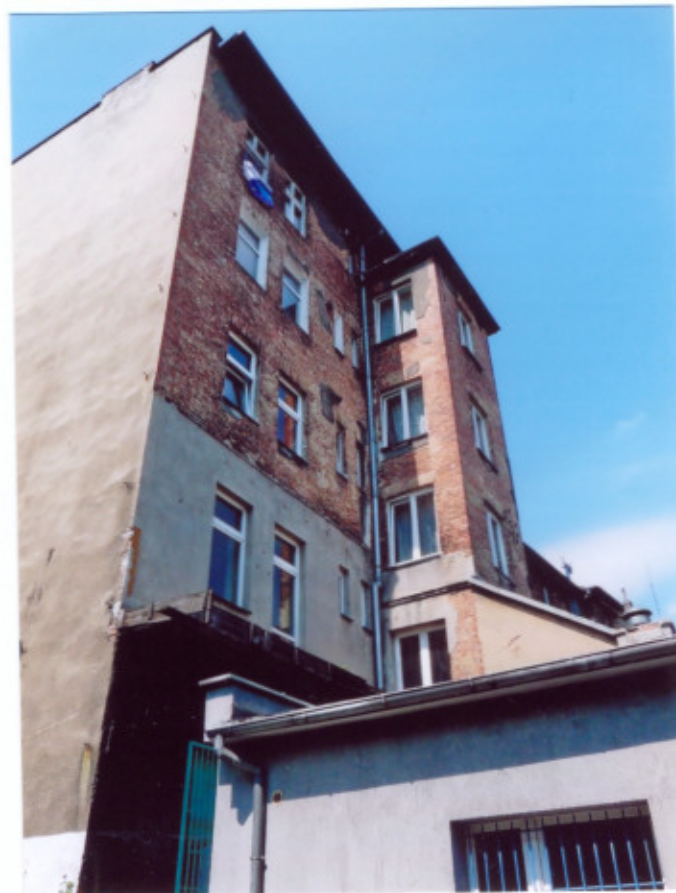
Frag. elewacji wschodniej.
