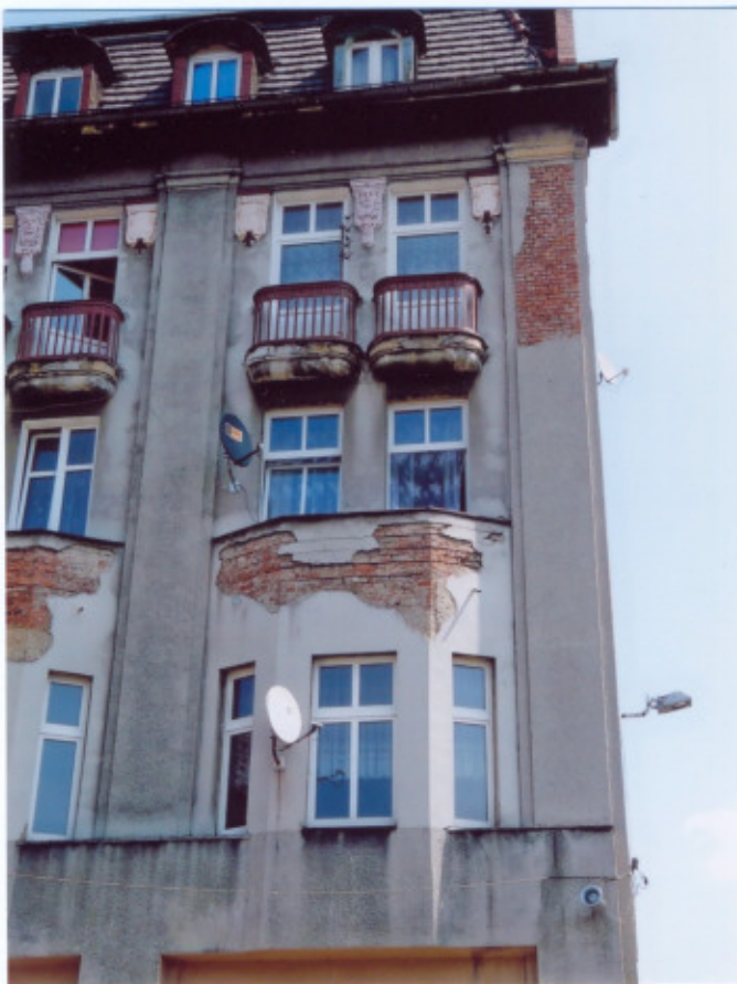
Fraq. elewacji zachodniej.
