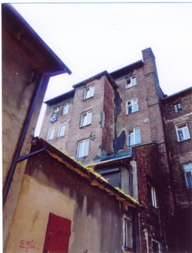
Frag. elewacji wschodniej.
