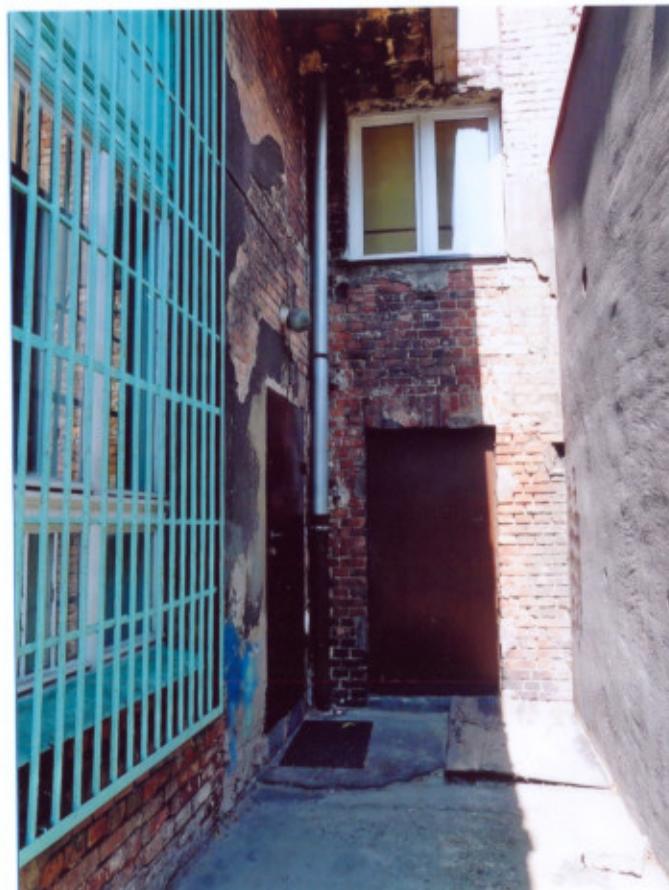
Frag. elewacji wschodniej. Drzwi.
