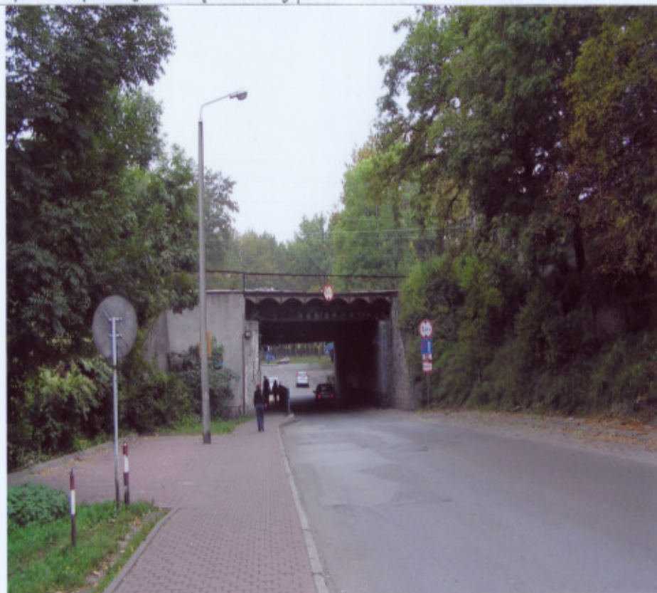
3 WIDOK MOSTU OD STRONY ZACHODNIEJ
