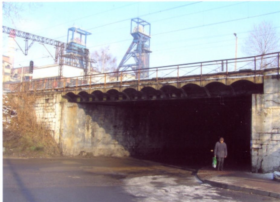
1 WIDOK MOSTU OD STRONY ZACHODNIEJ
