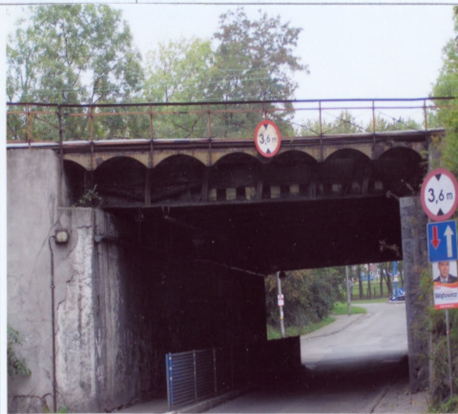
4 WIDOK MOSTU OD STRONY ZACHODNIEJ
