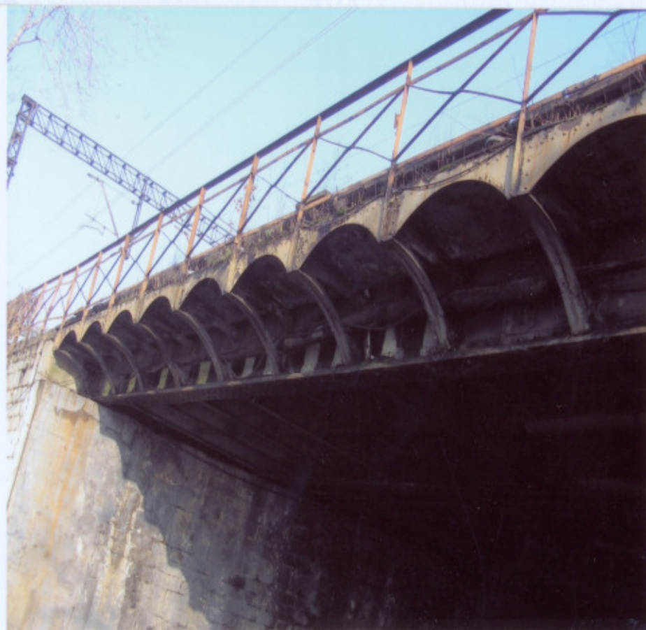
5 FRAGMENT STALOWEJ KONSTRUKCJI MOSTU
