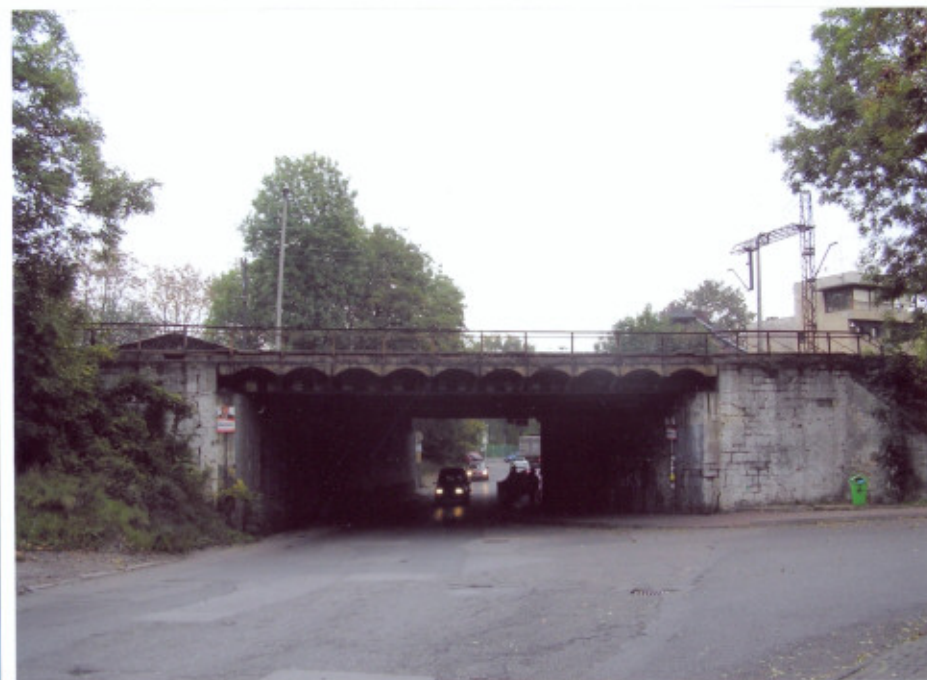
2 WIDOK MOSTU OD STRONY ZACHODNIEJ
