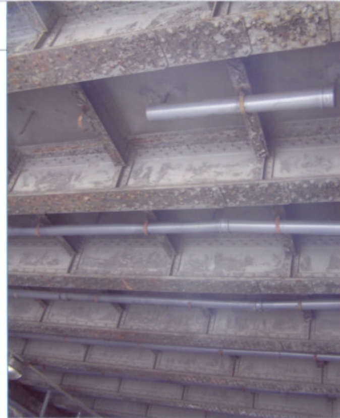
12 FRAGMENT STALOWEJ KONSTRUKCJI MOSTU (PODNEBIENIE)
