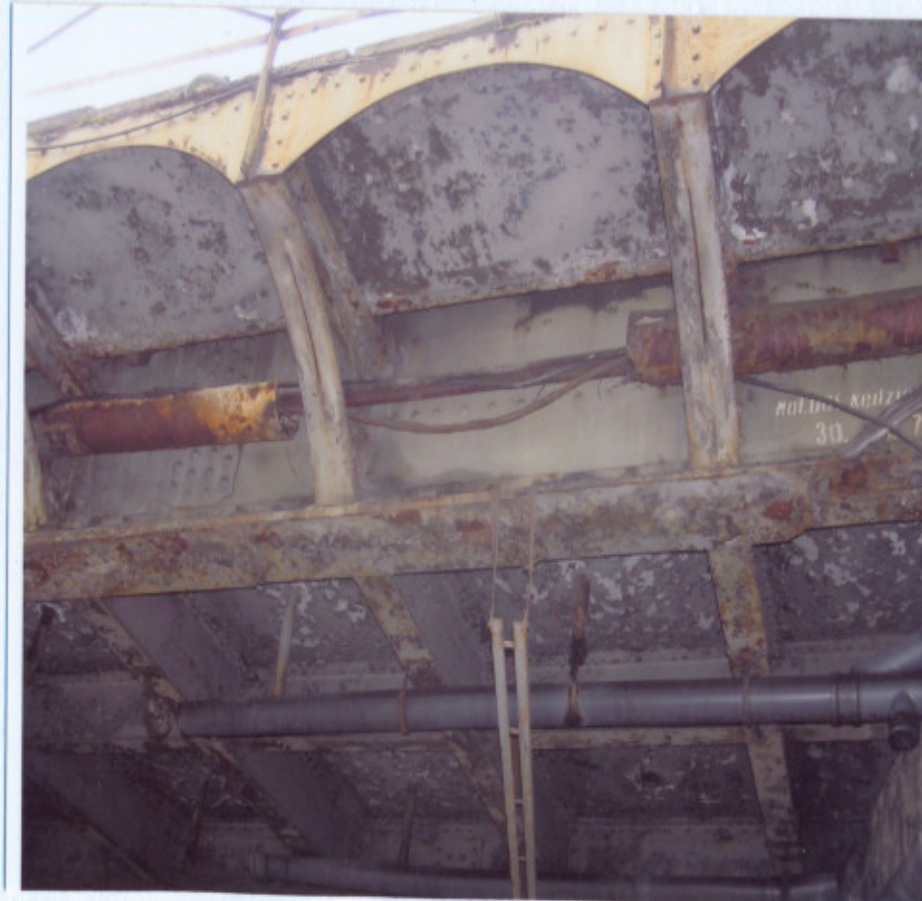
6 FRAGMENT STALOWEJ KONSTRUKCJI MOSTU
