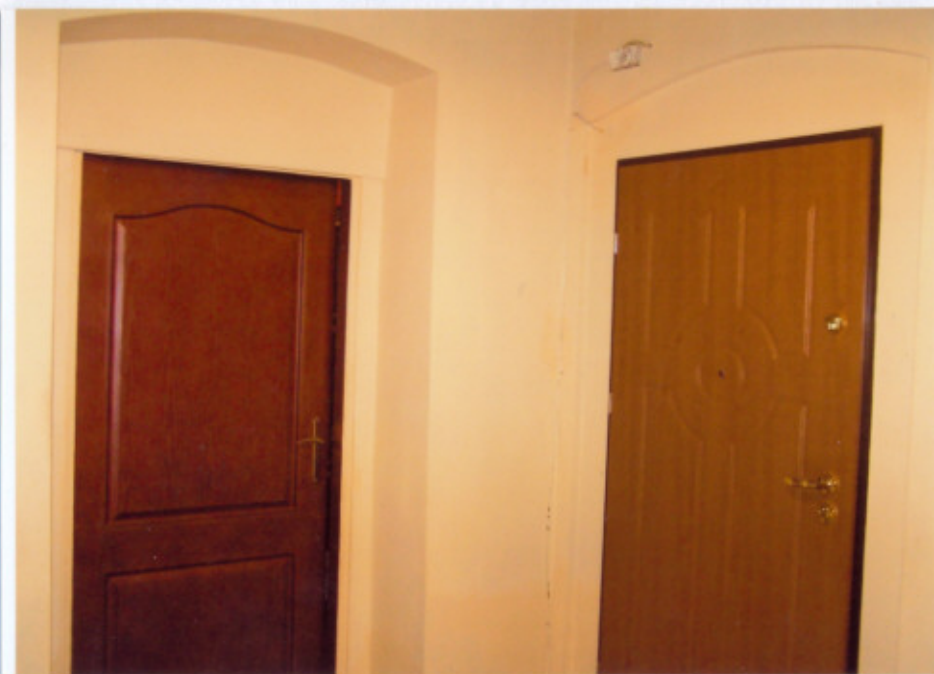
23 WTÓRNA STOLARKA Z KLATKI SCHODOWEJ KAMIENICY DO MIESZKAŃ (WIDOCZNE PIERWOTNE WIELKOŚCI OTWORÓW DRZWIOWYCH)
