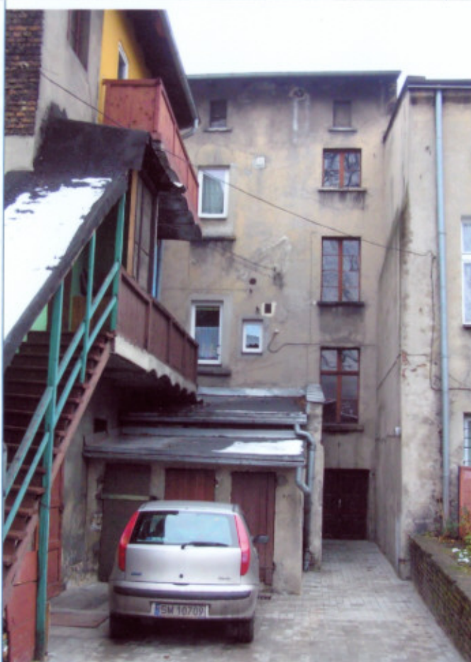
9 ELEWACJA TYLNA KAMIENICY Z DWIEMA PRZYBUDÓWKAMI I FRAGMENT OFICYNY
