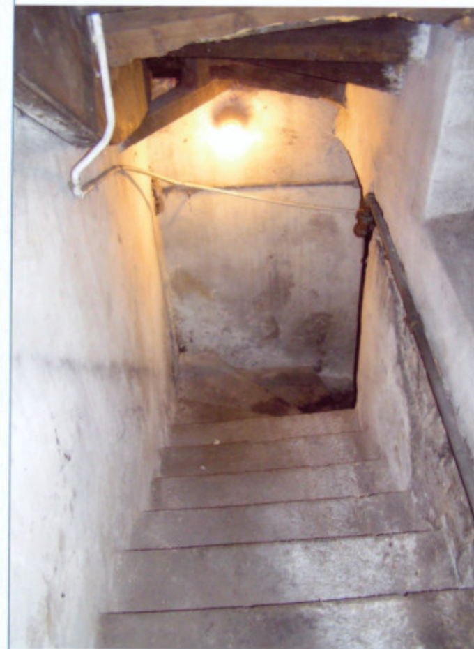
10 SCHODY DO PIWNICY
