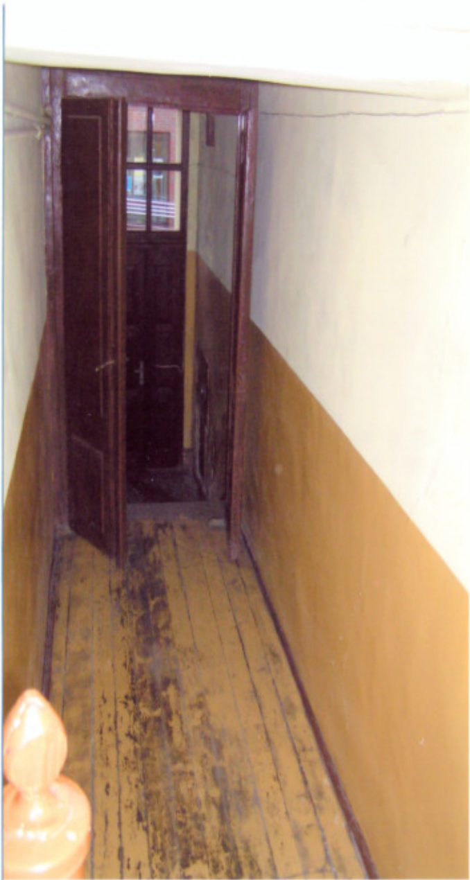
11 SIEŃ – WIDOK W KIERUNKU DRZWI GŁÓWNYCH
