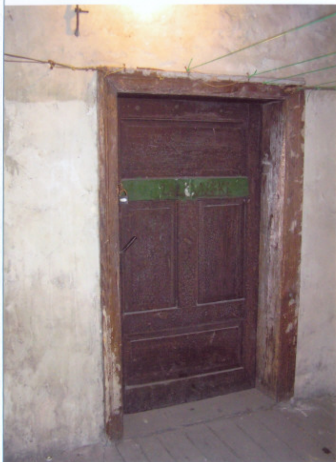
20 DRZWI W POMIESZCZENIU STRYCHOWYM
