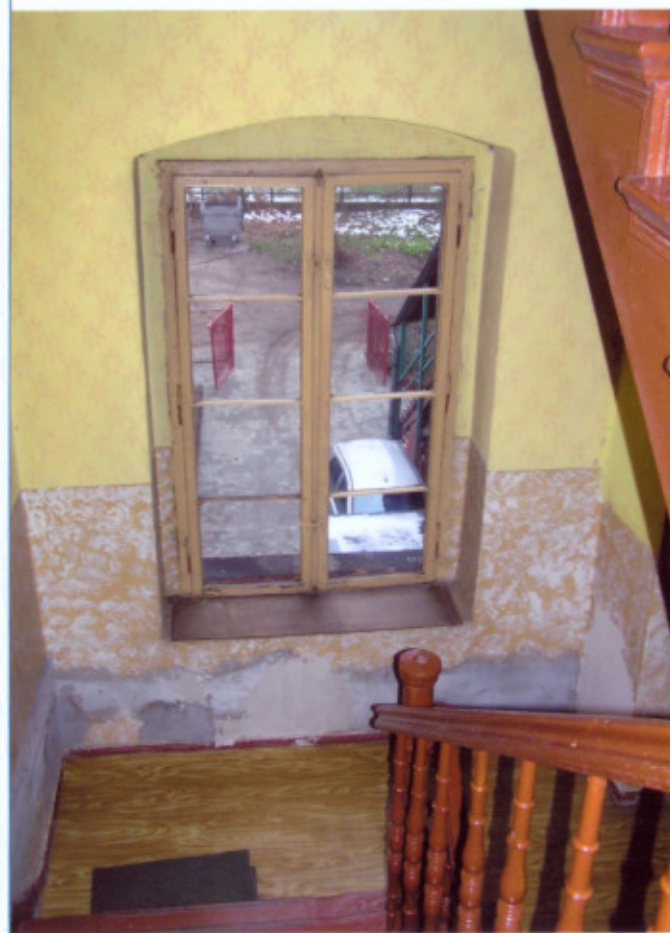
15 PIERWOTNA STOLARKA OKIENNA W KLATCE SCHODOWEJ WIDOK OD WEWNĄTRZ
