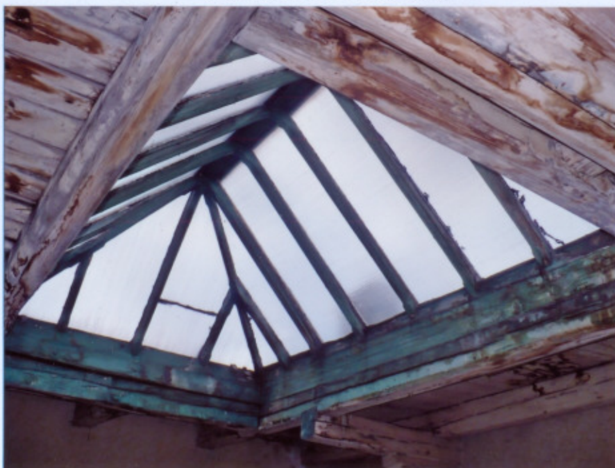
Świetlik nad klatką schodową
