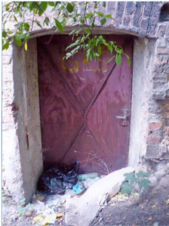
Drzwi do piwnic, elewacja wschodnia
