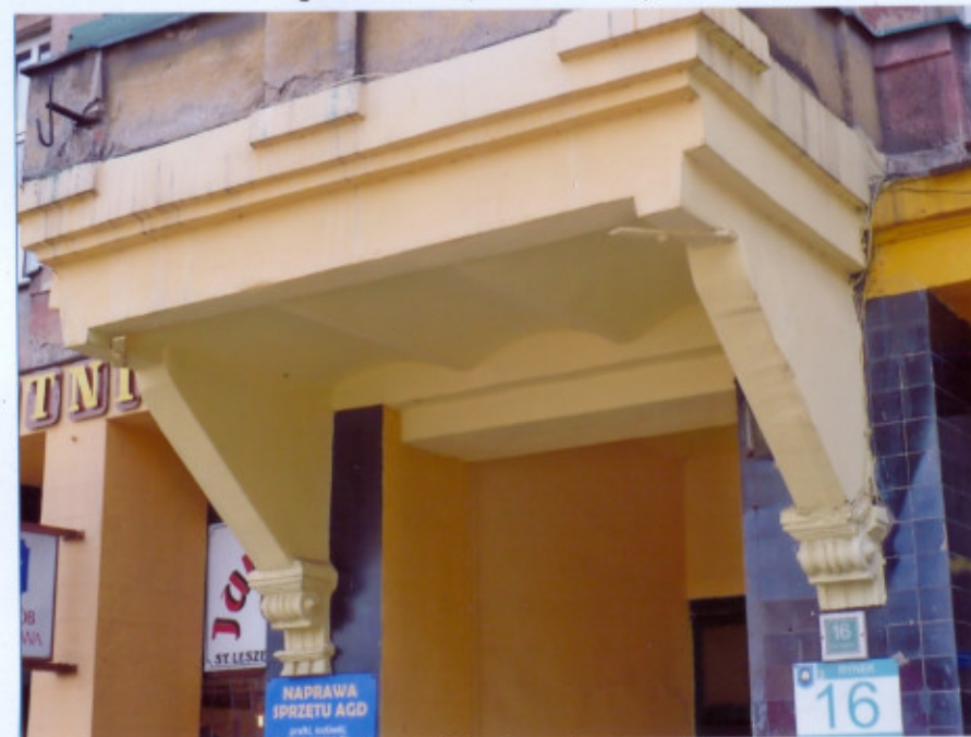
Fragment elewacji frontowej, wsporniki wykusza
