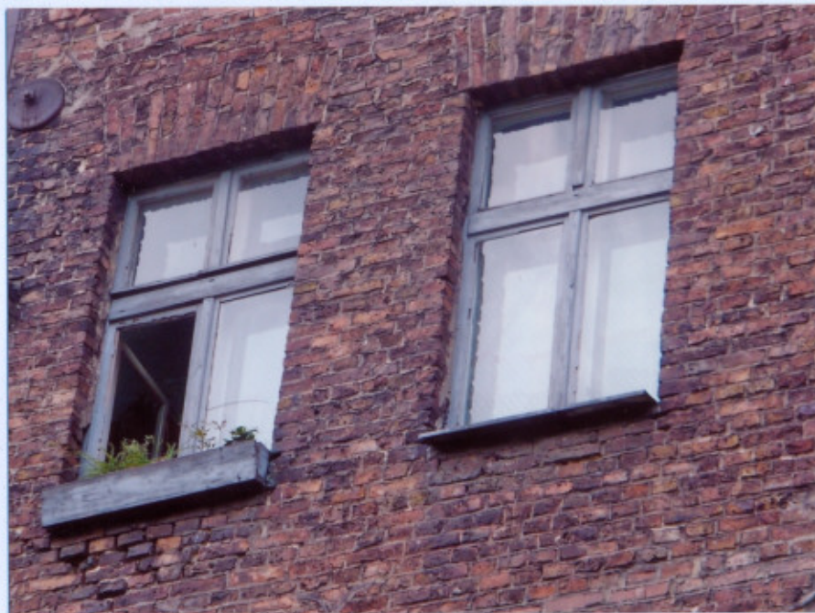
Okna na elewacji wschodniej
