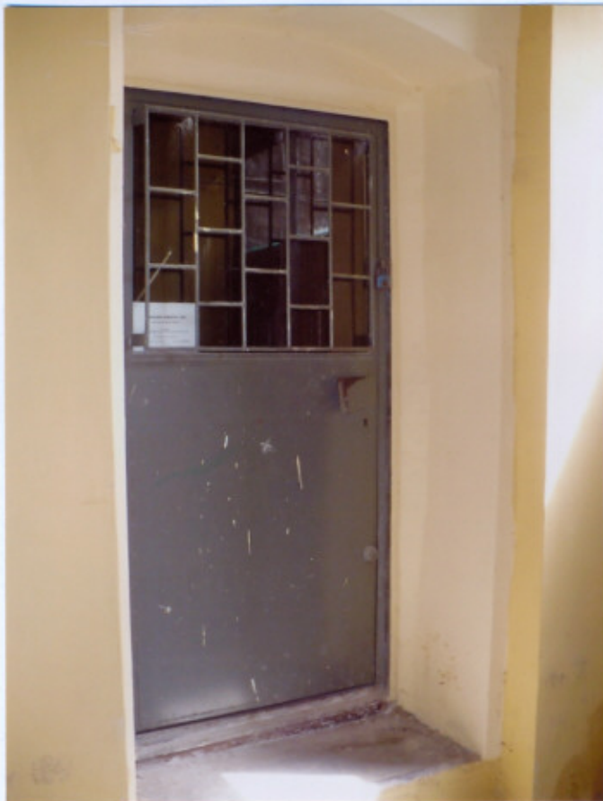
Drzwi wejściowe do lokalu użytkowego, parter, sień
