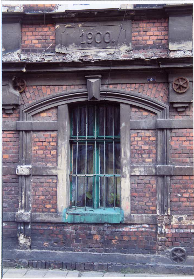
Fot. 10 Okno - elewacja zachodnia
