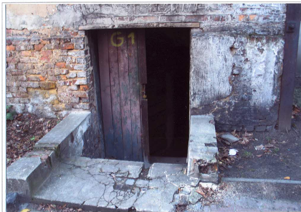
Fot. 14 Wejście do piwnicy
