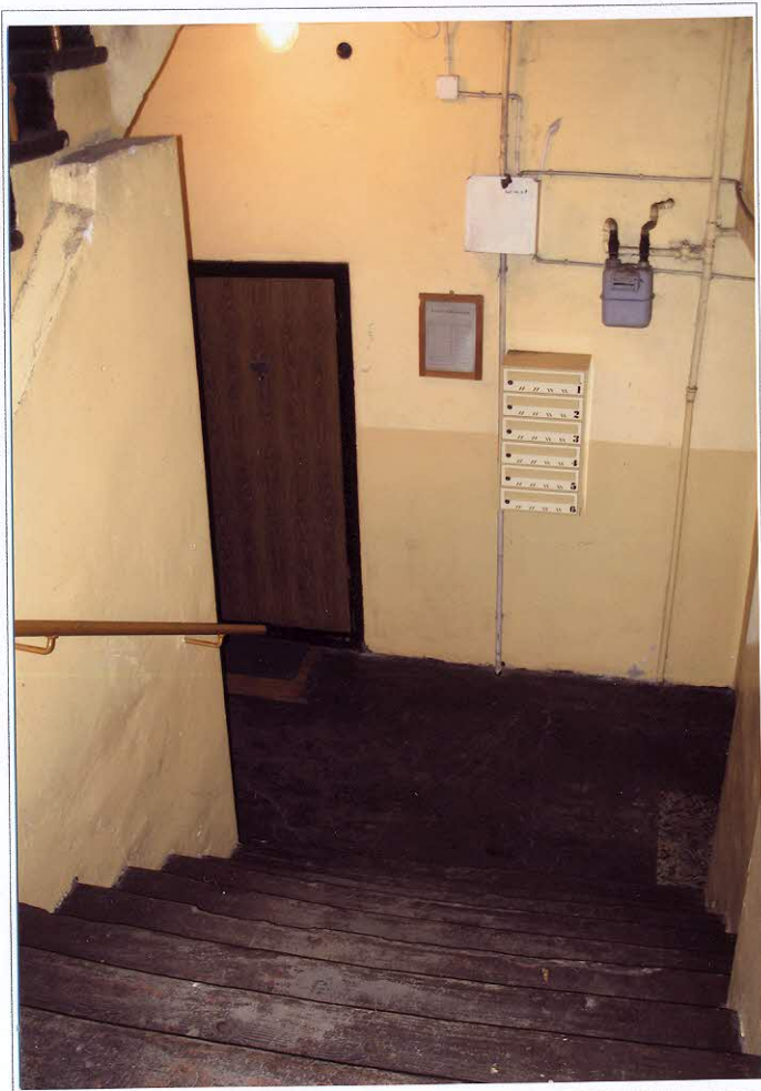
Fot. 19 Klatka schodowa
