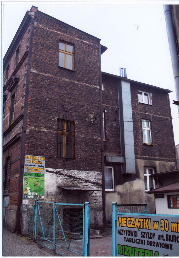
Fot. 4 Elewacja wschodnia
