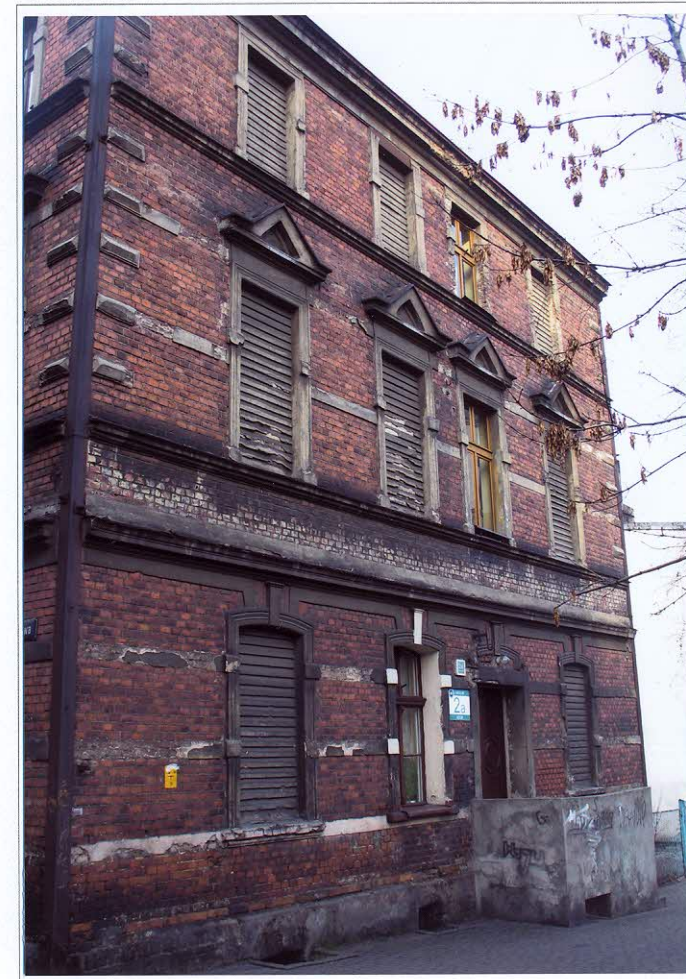
Fot. 3 Elewacja południowa
