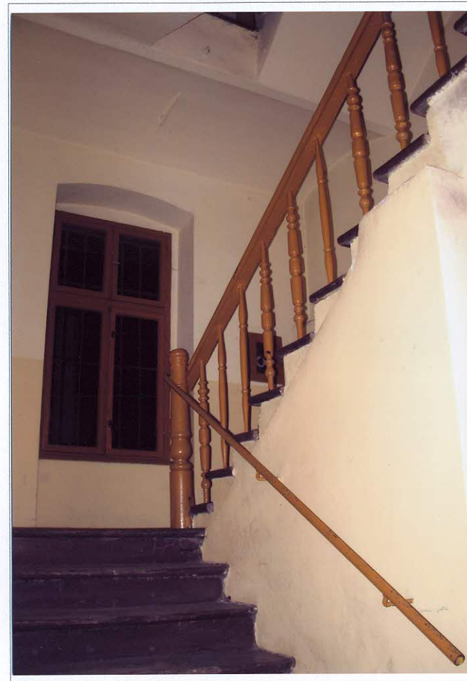
Fot. 18 Klatka schodowa
