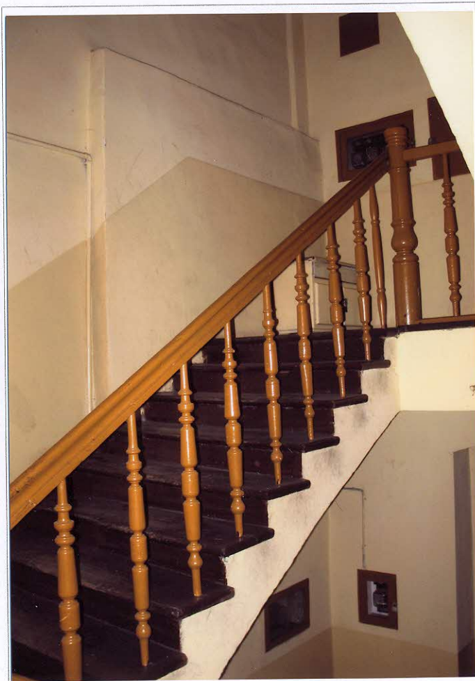
Fot. 20 Klatka schodowa
