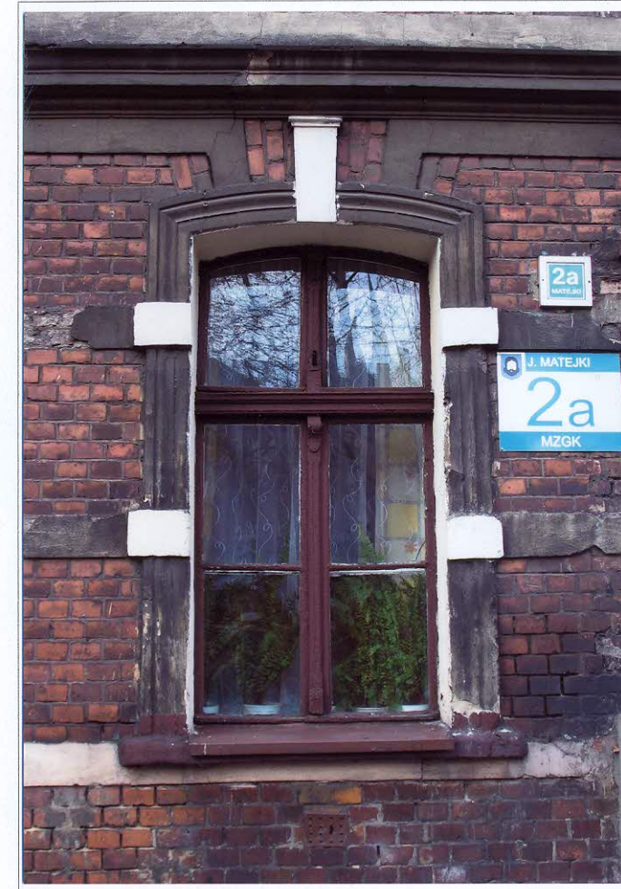
Fot. 9 Okno - elewacja frontowa
