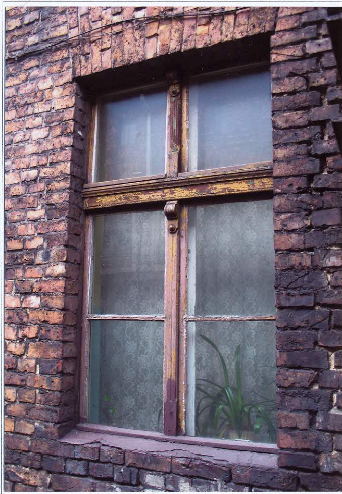
Fot. 11 Oryginalna stolarka okienna - elewacja tylna
