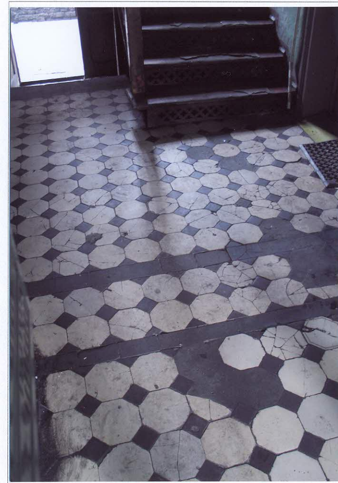
Fot. 13 Posadzka w korytarzu na parterze
