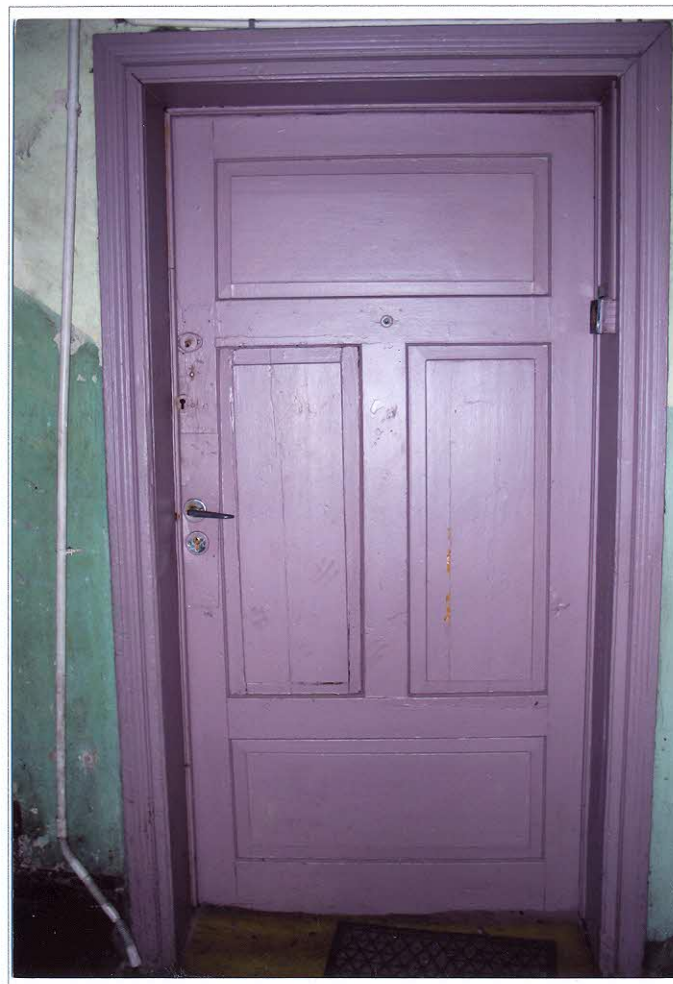
Fot. 20 Zachowana oryginalna stolarka drzwiowa na parterze
