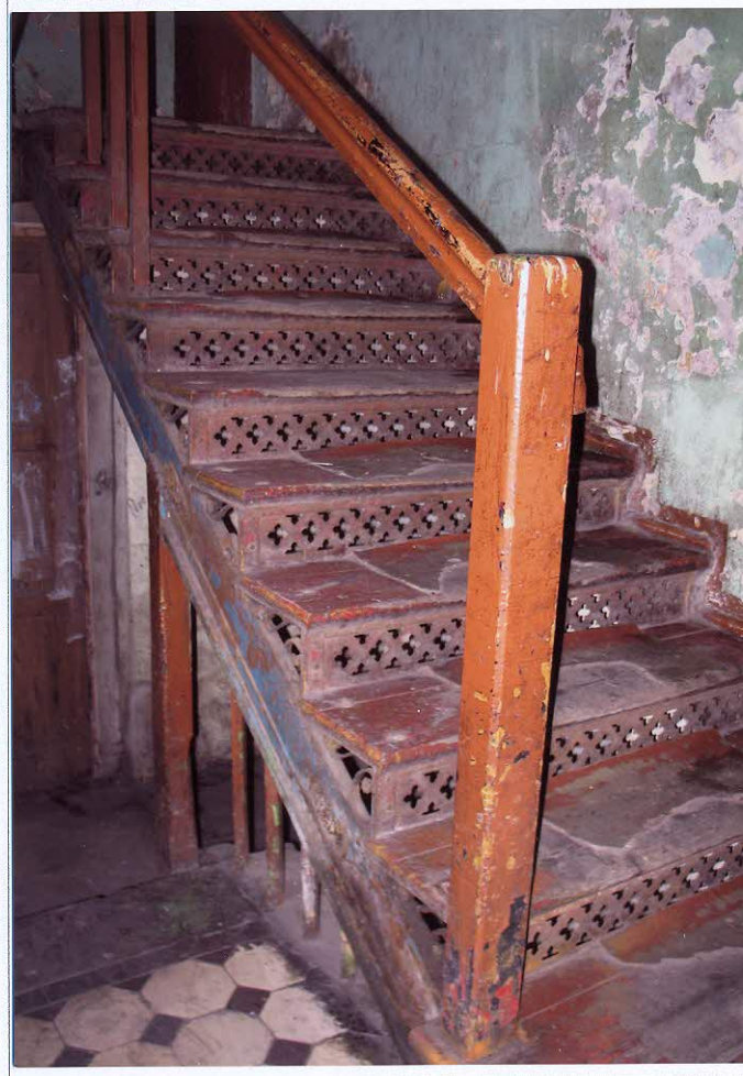
Fot. 15 Klatka schodowa
