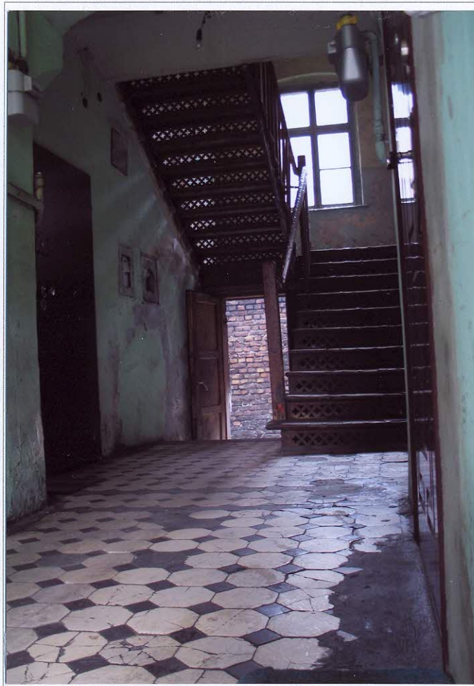
Fot. 12 Korytarz na parterze z widokiem na klatkę schodową
