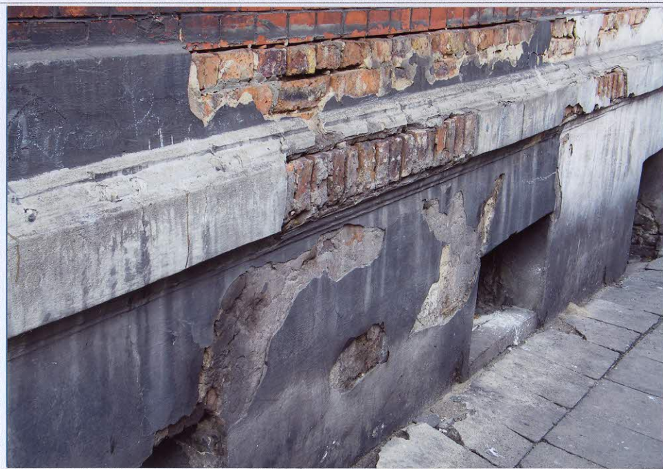
Fot. 9 Cokół elewacji frontowej
