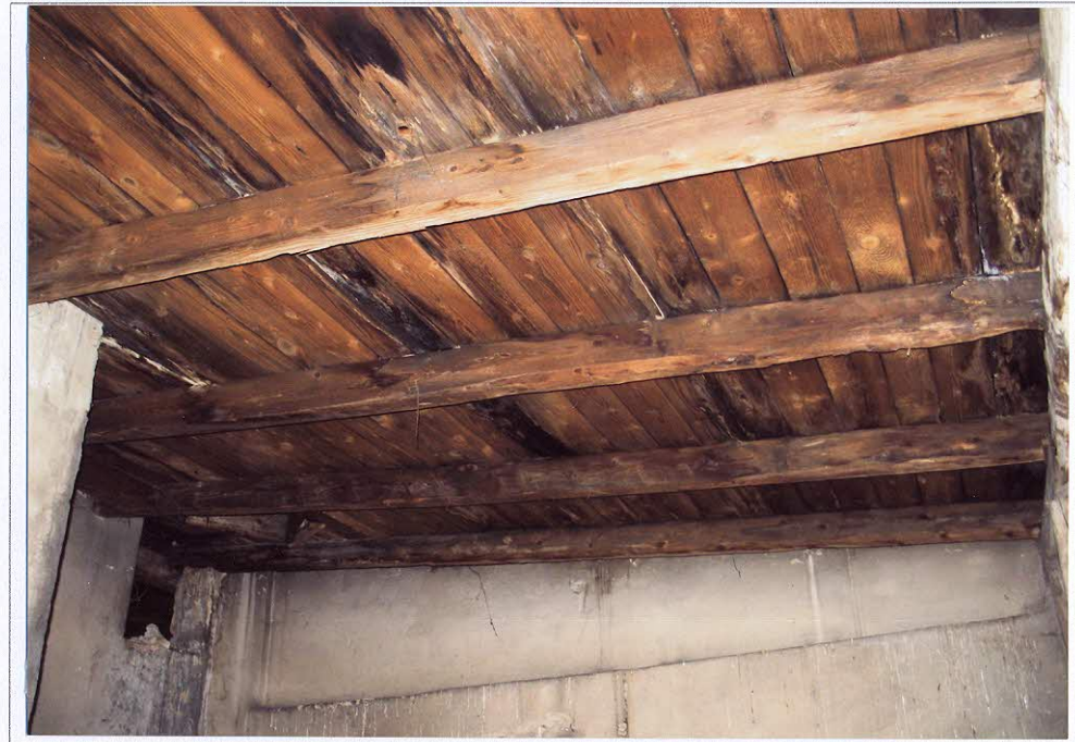
Fot. 18 Fragment więźby dachowej
