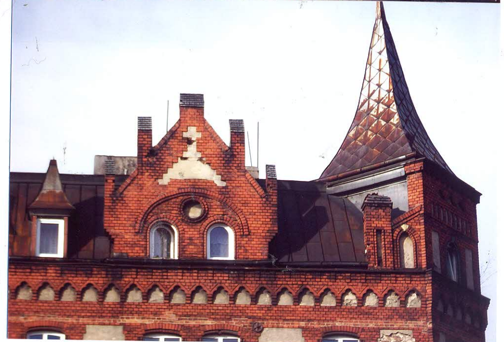
Obramowanie okien i pas zdobień pomiędzy drugą a trzecią kondygnacją - widok od strony ul. Oświęcimskiej Czwarta kondygnacja, pokrycie dachu Wieżyczka z attyką
