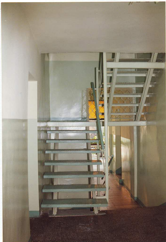
GLÓWNA KLATKA SCHODOWA
