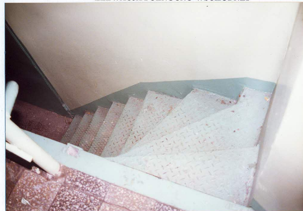
WEWNĘTRZNE SCHODY DO PIWNIC
