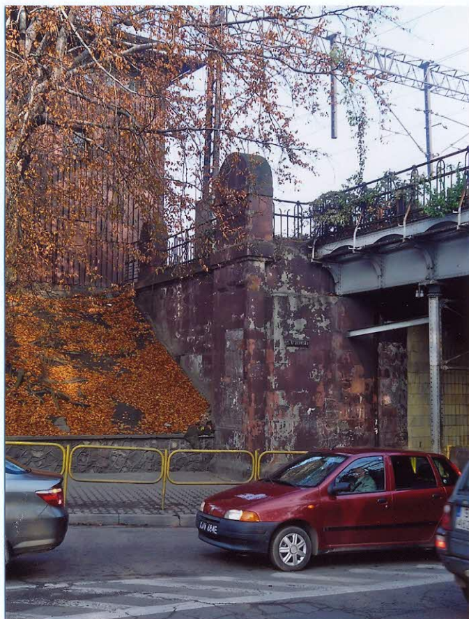
Lewe skrzydło podpory. Widok od zachodu.
