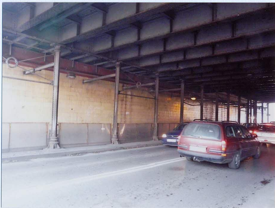
Widok ogólny. Słupy wiaduktu.
