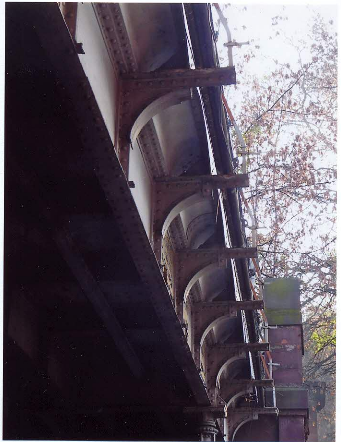
Frag. dolnego dźwigara.
