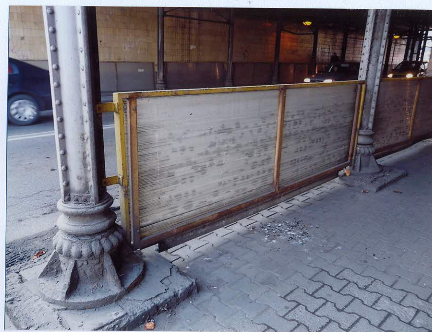
Bariera oddzielająca ciągi komunikacyjne.
