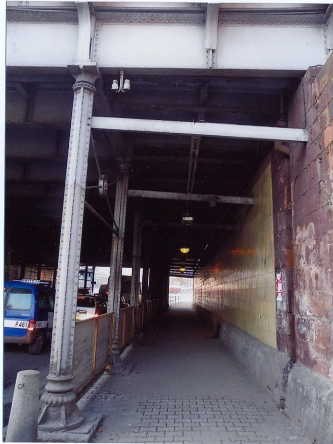
Ciąg komunikacyjny. Widok ogólny.
