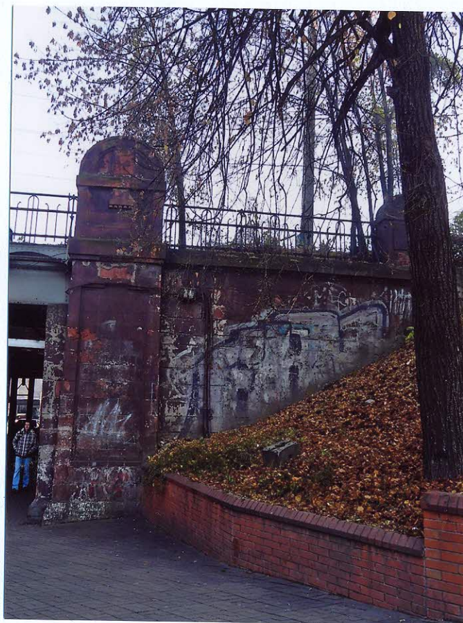
Prawe skrzydło podpory. Widok od zachodu.
