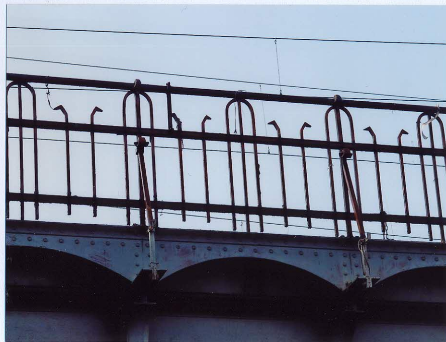
Frag. balustrady wiaduktu.
