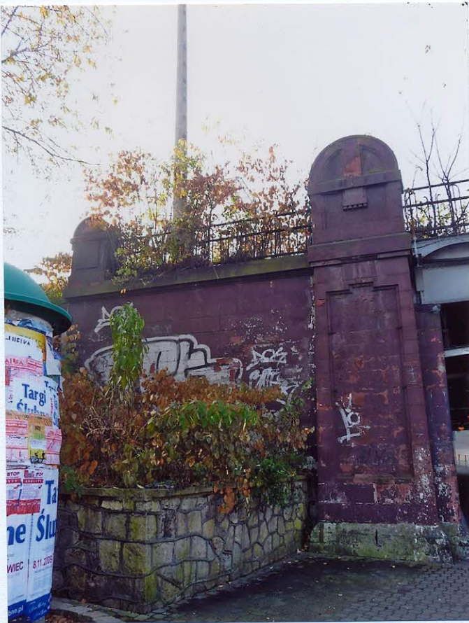
Lewe skrzydło podpory. Widok od wschodu.
