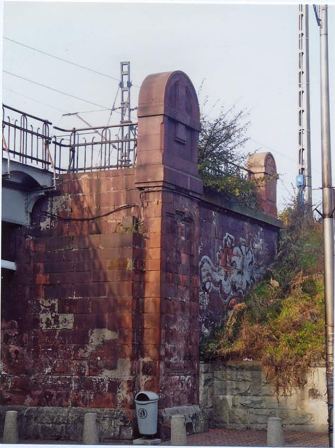
Prawe skrzydło podpory. Widok od wschodu.
