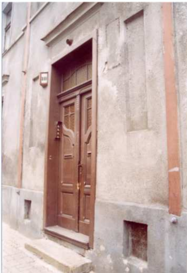
4. Frag. elewacji wschodniej. Drzwi.
