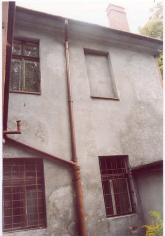
14. Frag. elewacji zachodniej (tylnej).
