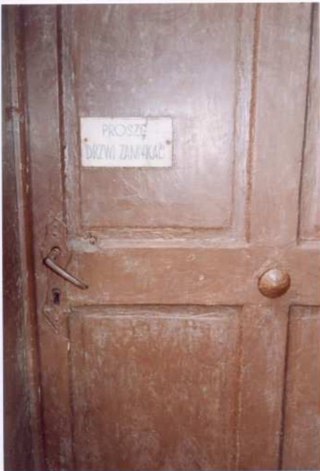
13. Frag. elewacji zachodniej (tylnej). Drzwi - detal.
