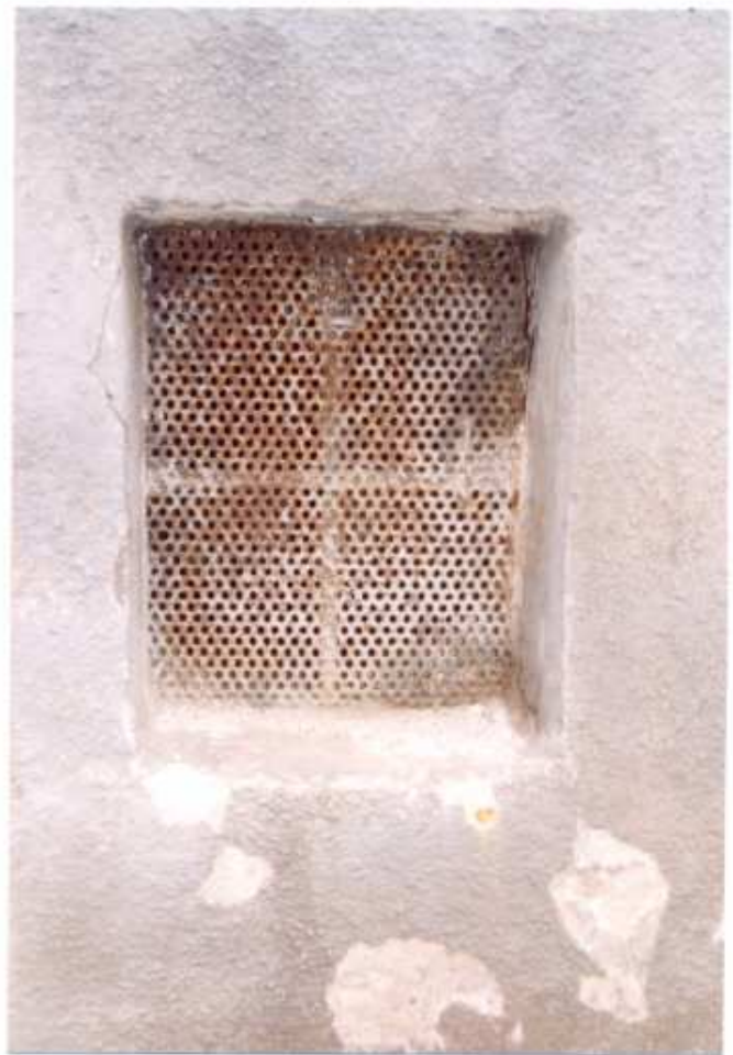
8. Frag. elewacji wschodniej. Okno piwniczne.
