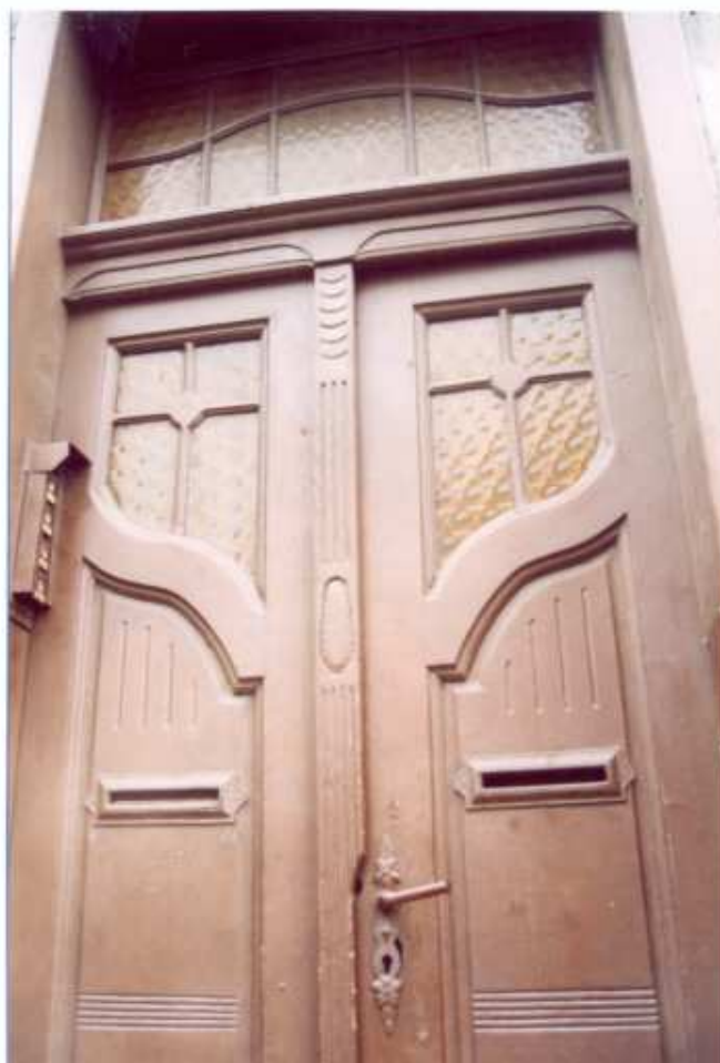
5. Frag. elewacji wschodniej. Drzwi-detale.
