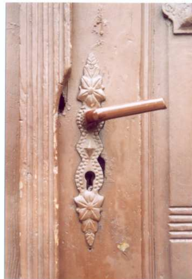
6. Frag. Elewacji wschodniej. Drzwi-klamka.
