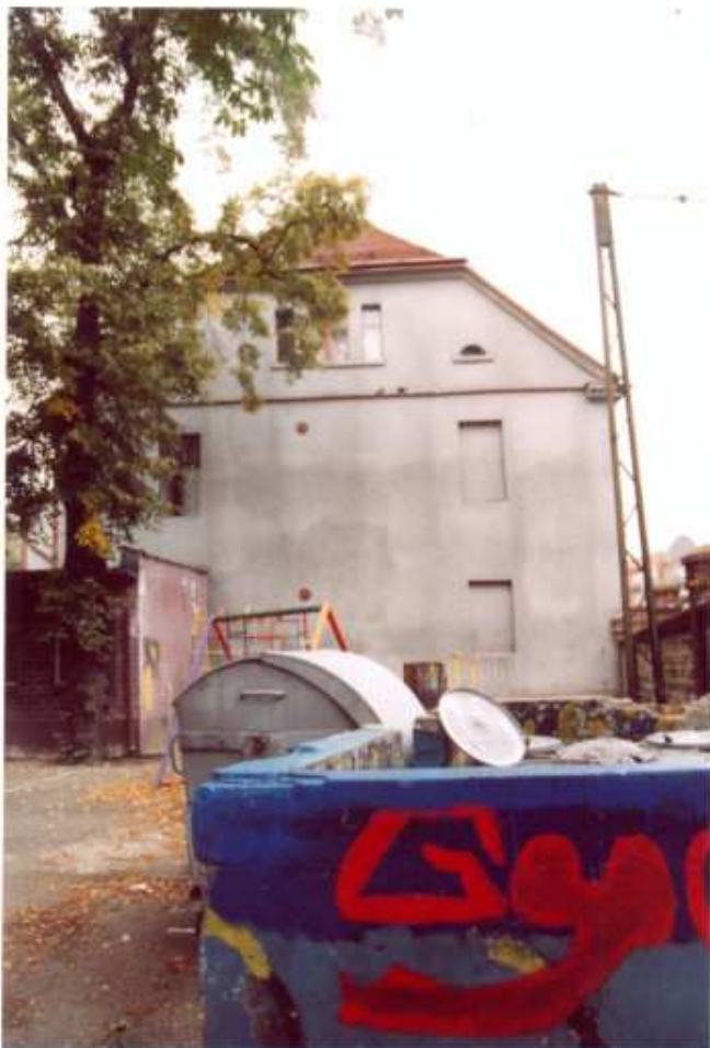
9. Elewacja południowa. Widok ogólny.
