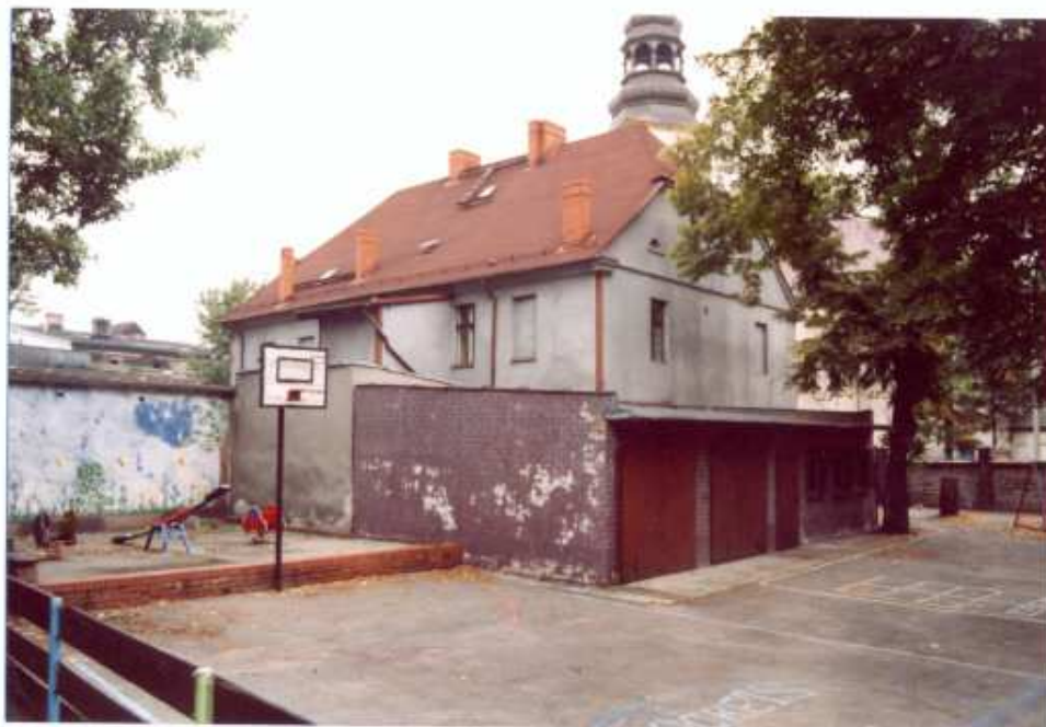
11. Elewacja zachodnia (tylna). Widok od południowego-zachodu.
