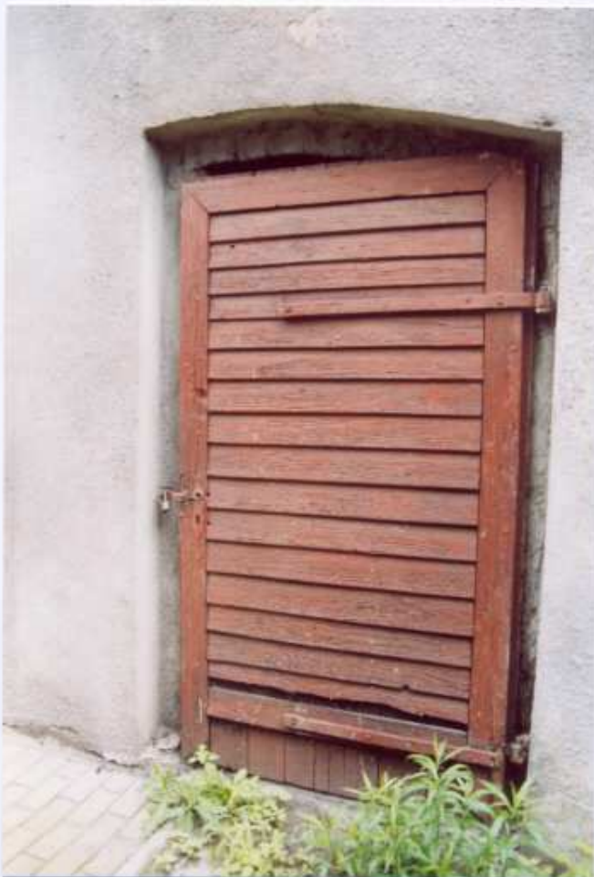
15. Frag. elewacji zachodniej (tylnej). Dobudówka - drzwi.
