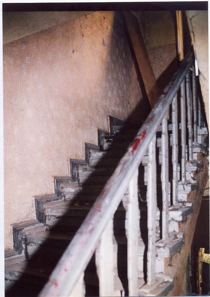
19. Oficyna północna.. Klatka schodowa.
