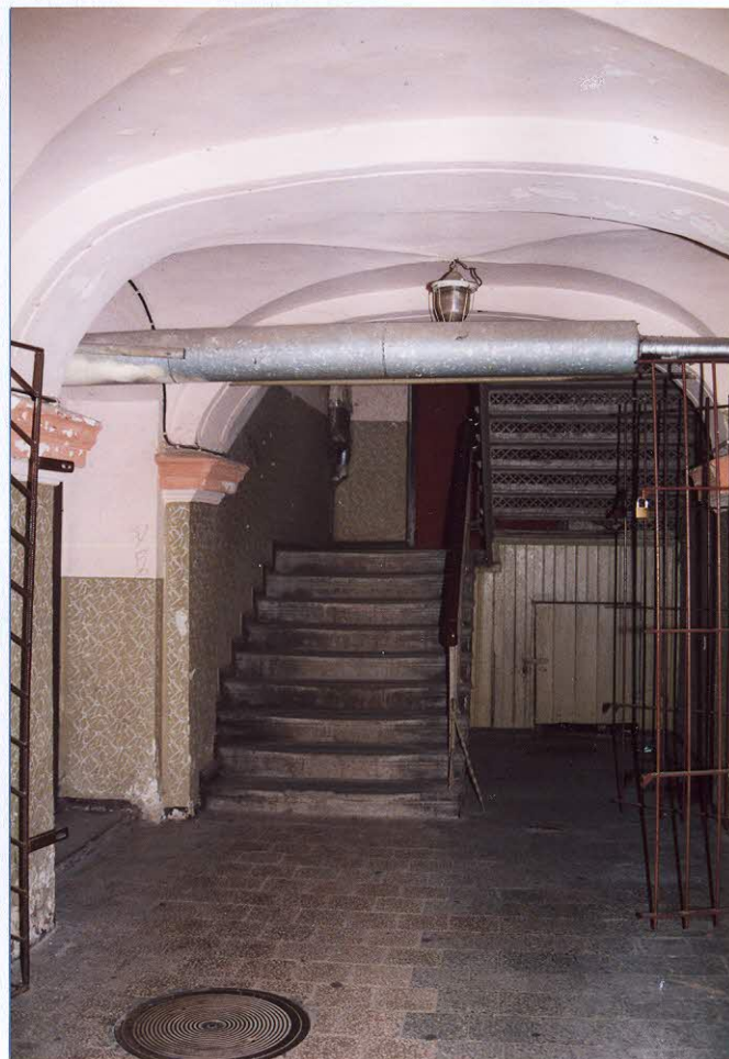
16. Frag. klatki schodowej.
