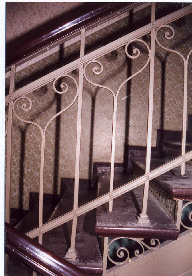
17. Główna klatka schodowa. Balustrada.
