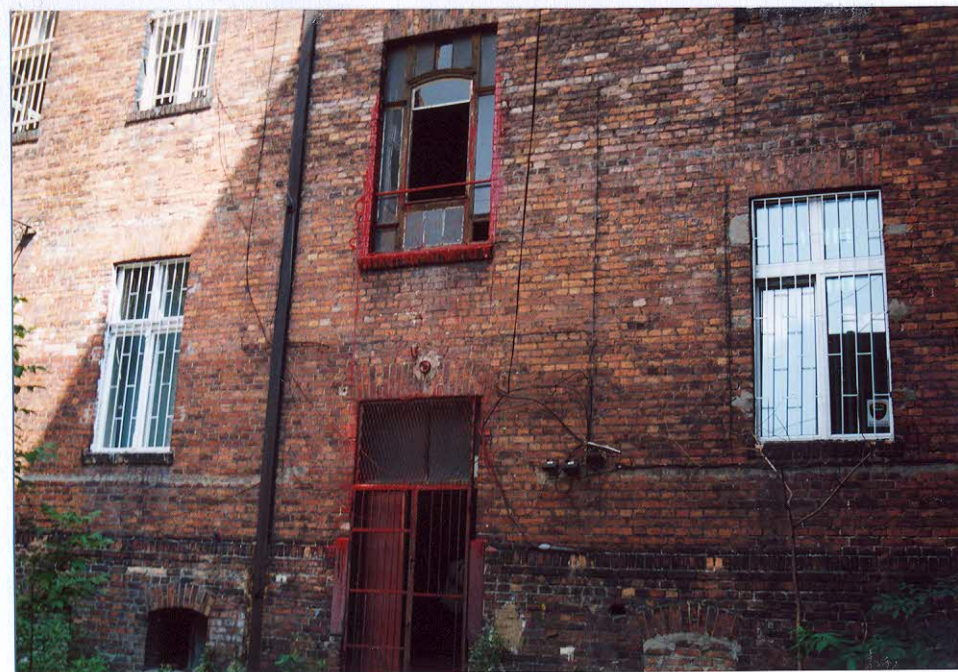
9. Frag. elewacji zachodniej - tylnej.
