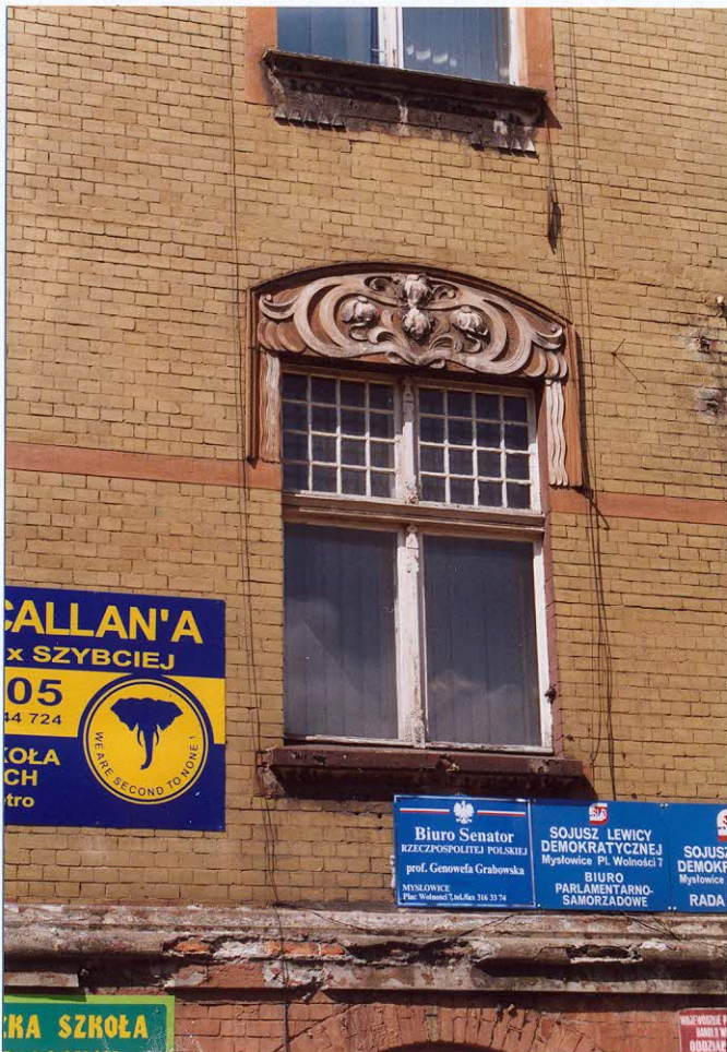
4. Frag. elewacji wschodniej. Okno.
