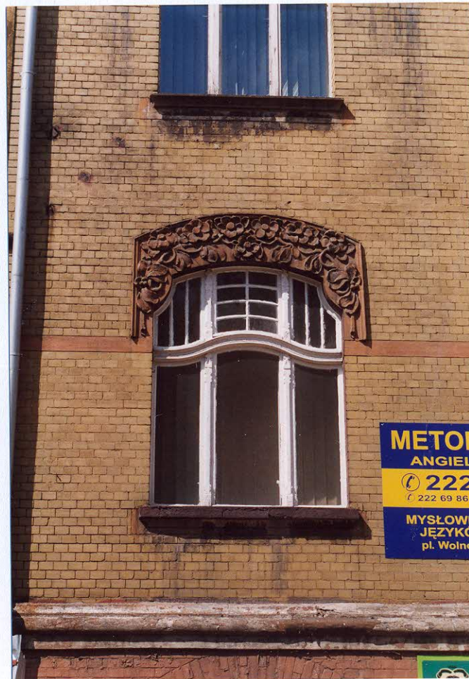
5. Frag. elewacji wschodniej. Okno.
