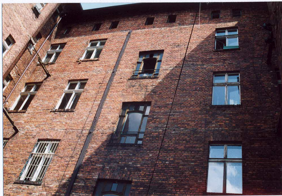
8. Frag. elewacji zachodniej - tylnej.
