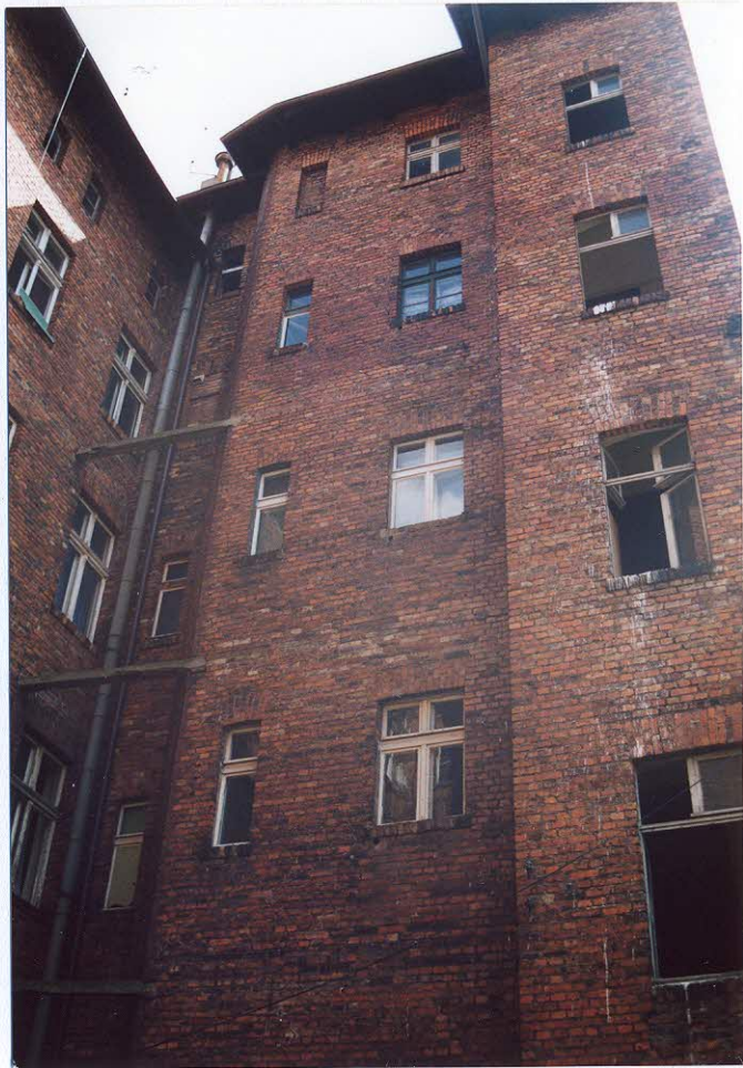
12. Oficyna południowa. Frag. elewacji północnej.
