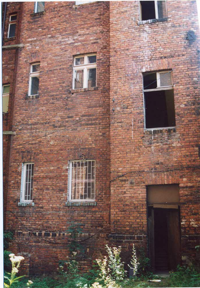
13. Oficyna południowa. Frag. elewacji północnej..
