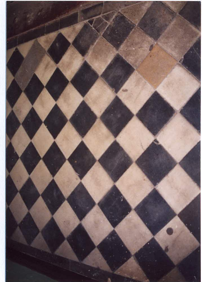
24. Klatka schodowa. Posadzka.
