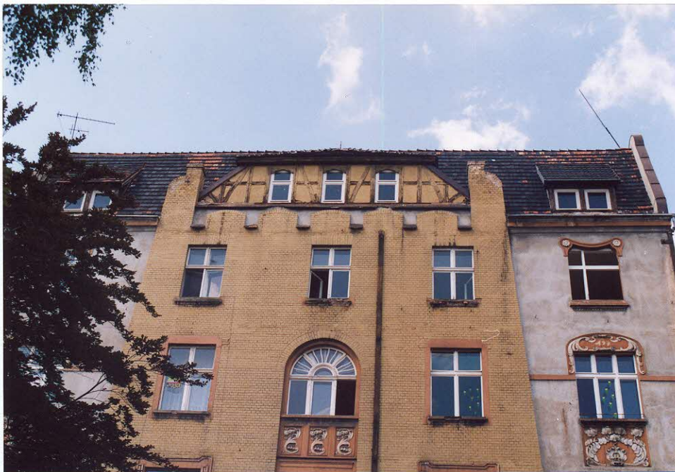
3. Frag. elewacji wschodniej-frontowej. Szczyt.
