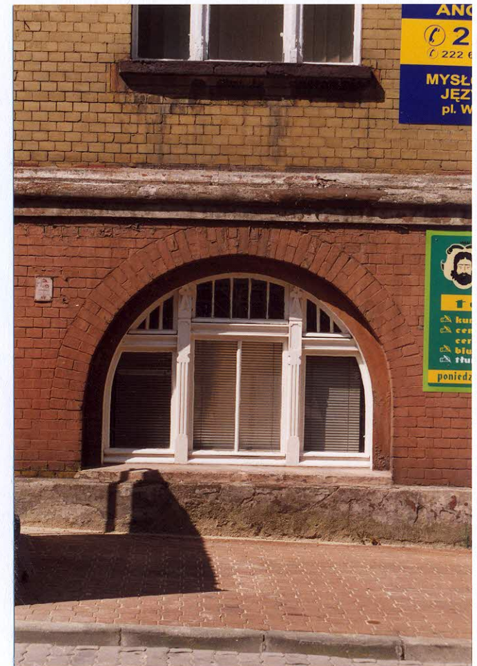
6. Frag. elewacji wschodniej. Okno.
