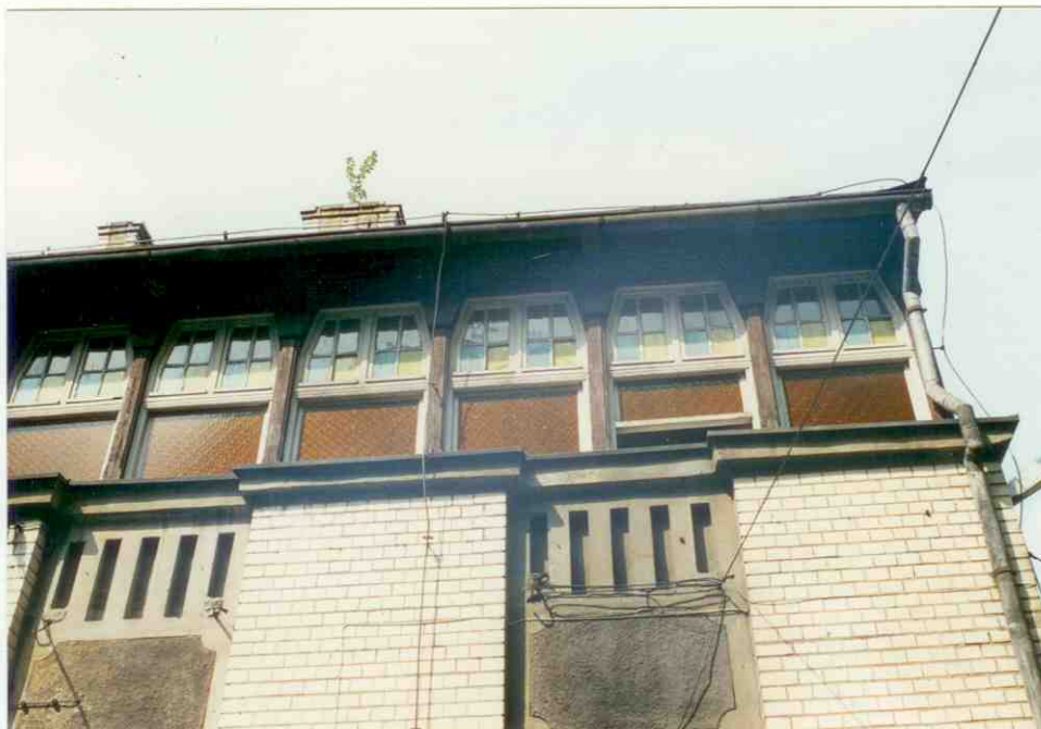
FRAGMENT ELEWACJI PŁD.-WSCH. OKNA WERANDY
