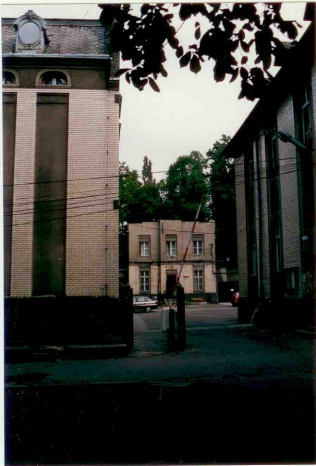
WJAZD DO ZESPOŁU SZPITALNEGO FRAGMENT ELEWACJI PŁN.-ZACH.
