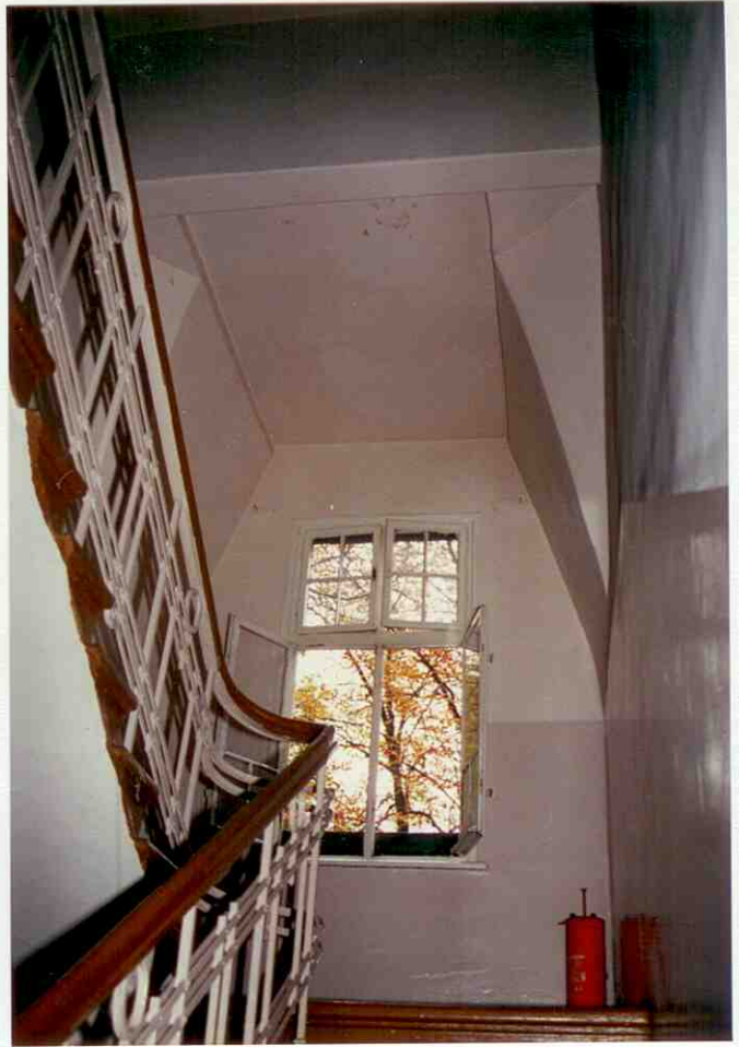
GŁÓWNA KLATKA SCHODOWA
