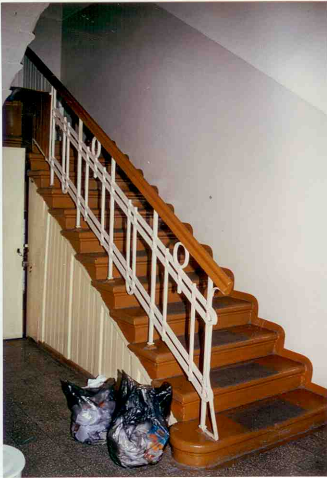
GŁÓWNA KLATKA SCHODOWA
