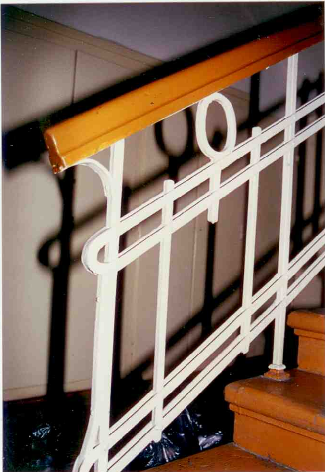
BALUSTRA DA KLATKI SCHODOWEJ
