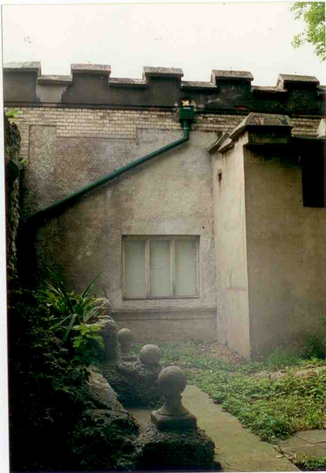
4. Fragment elewacji północno-wschodniej.
