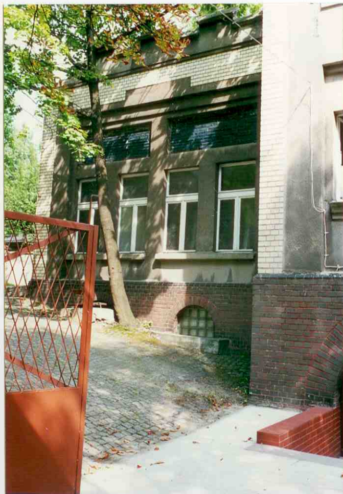
11. Fragment elewacji południowo-zachodniej.
