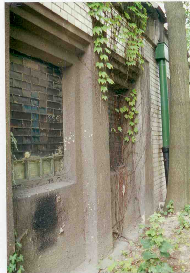
5. Fragment elewacji północno-wschodniej.
