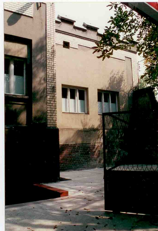
13. Fragment elewacji południowo-zachodniej.
