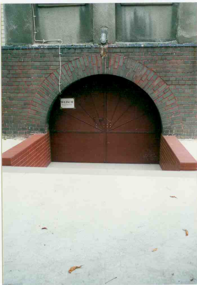
14. Drzwi. Fragment elewacji południowo-zachodniej.
