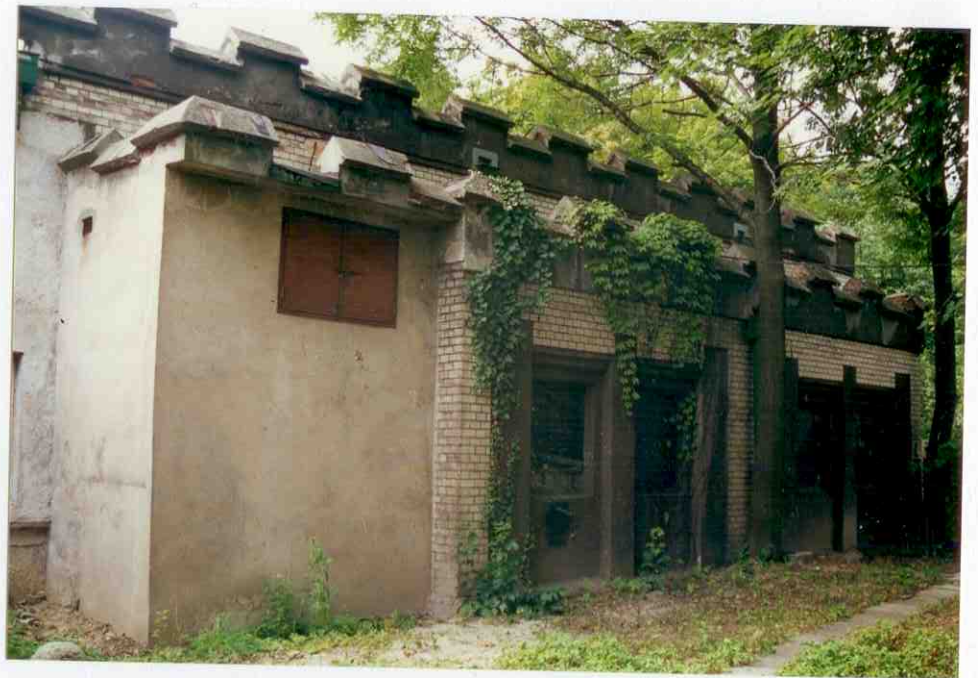
7. Fragment elewacji północno-wschodniej.
