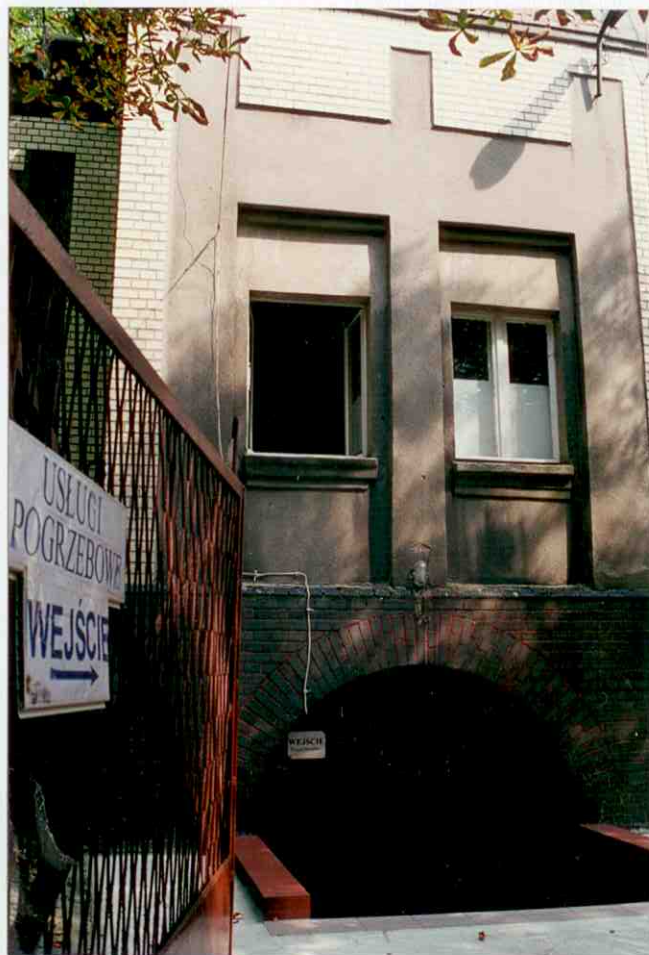
12. Fragment elewacji południowo-zachodniej.
