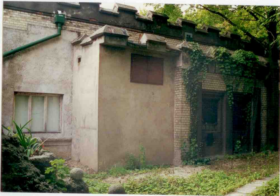
6. Fragment elewacji północno-wschodniej.
