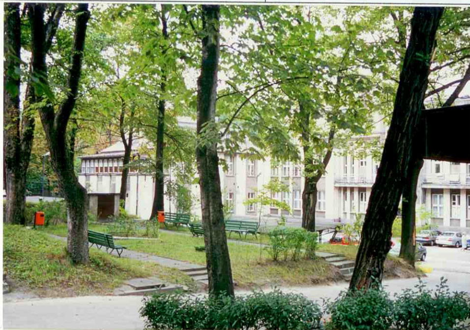
ZESPÓŁ SZPITALNY – widok pawilonu głównego i bocznego
