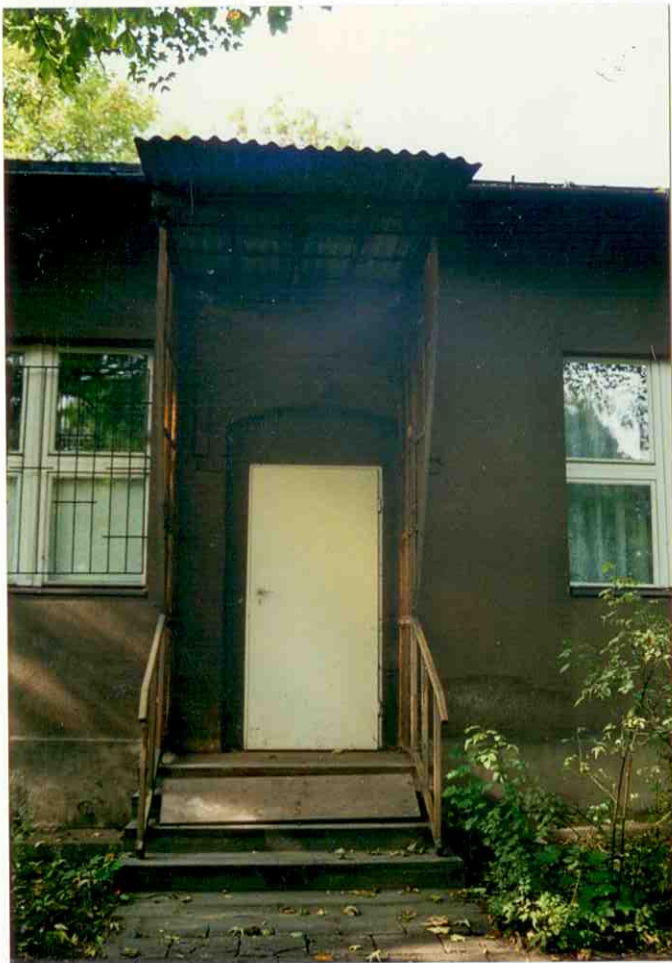
WEJŚCIE BOCZNE NA ELEWACJI PŁN.-WSCH.
