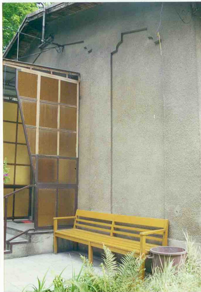
WEJŚCIE BOCZNE NA ELEWACJI PŁN.-WSCH.
