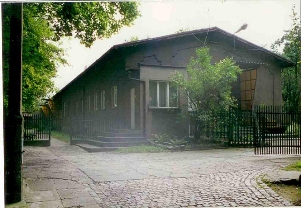
WIDOK ELEWACJI FRONTOWEJ
