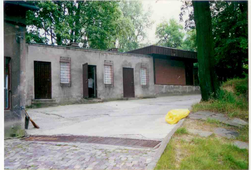
WNĘTRZE ZESPOŁU – wschodni ciąg zabudowy gospodarczej
