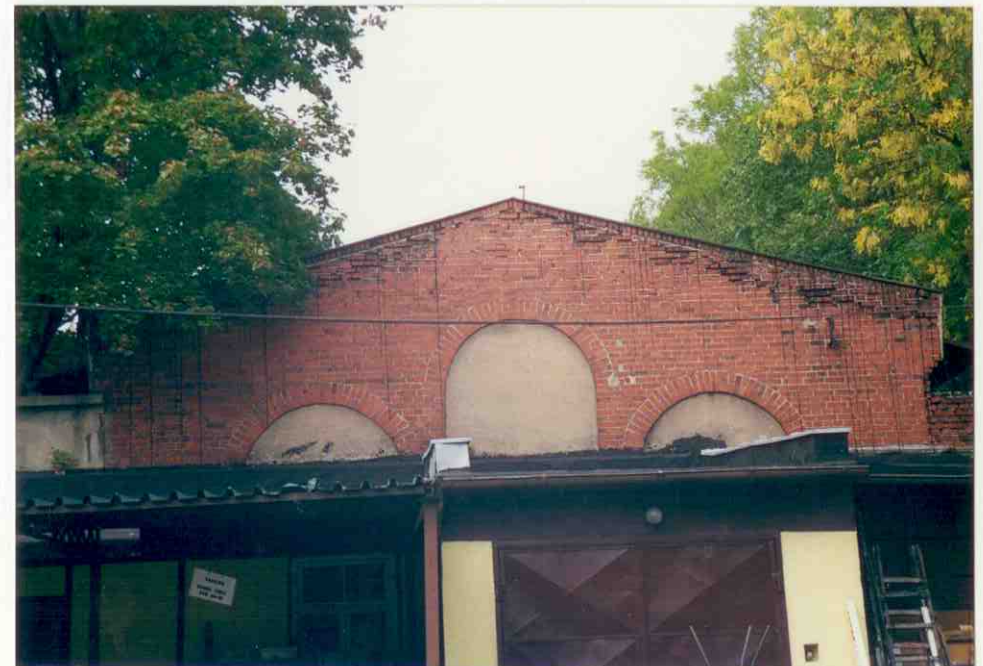
POŁUDNIOWO-WSCHODNIA ŚCIANA SZCZYTOWA
