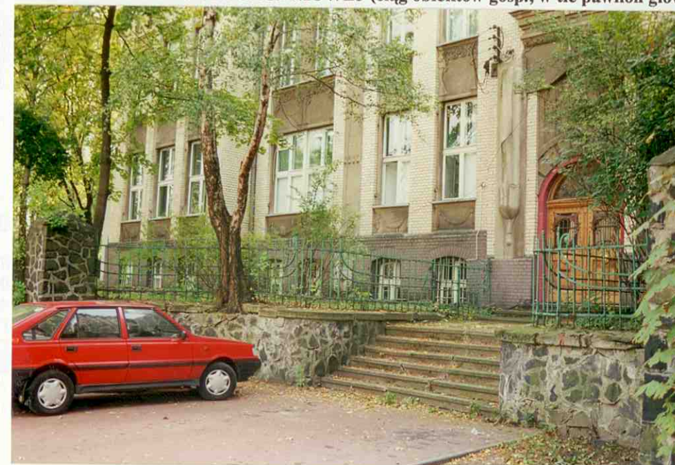
FRAGMENT OGRODZENIA PRZED PAWILONEM GŁÓWNYM
