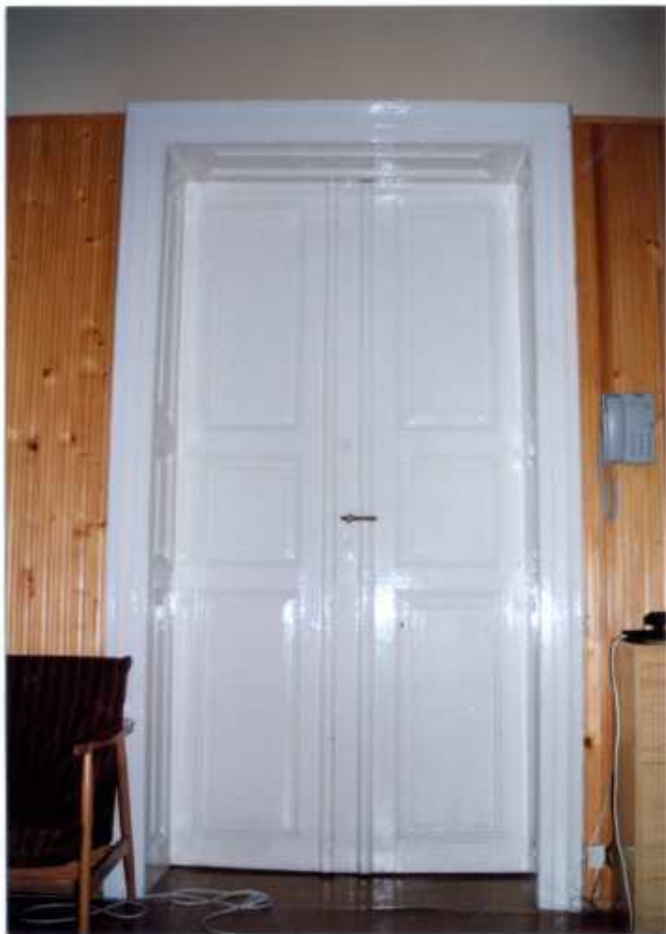
18 - DRZWI WEWNĘTRZNE NA PIĘTRZE
