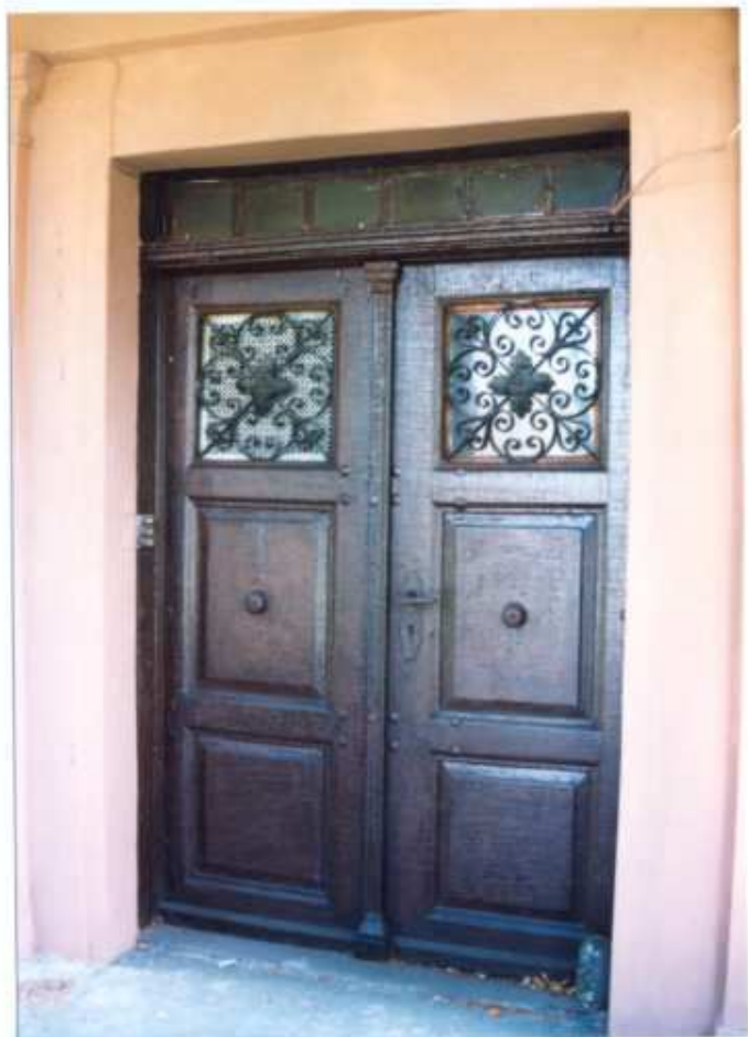
8 - DRZWI ZEWNĘTRZNE W ELEWACJI PÓŁNOCNEJ
