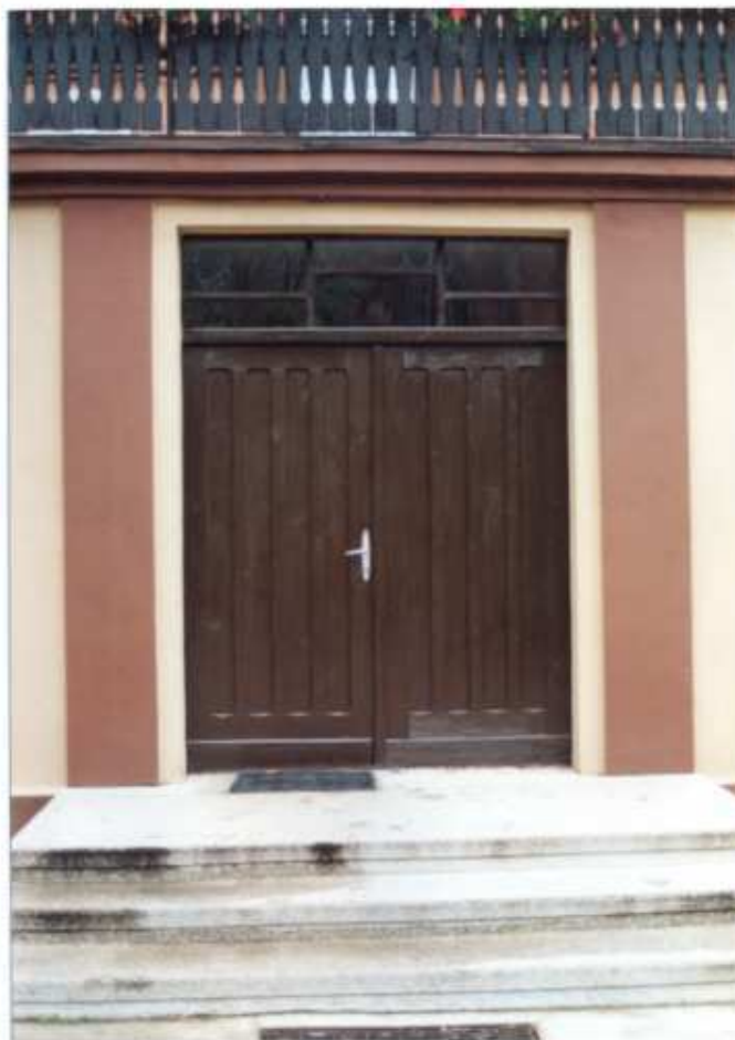
9 - DRZWI ZEWNĘTRZNE W ELEWACJI POŁUDNIOWEJ
