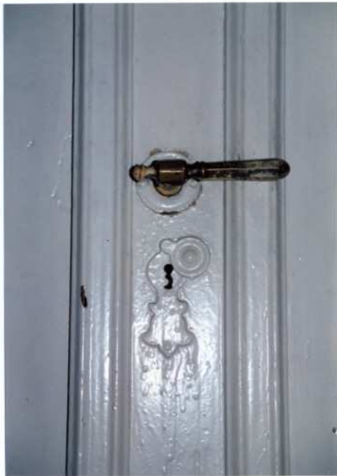
19 - DRZWI WEWNĘTRZNE NA PIĘTRZE FRAGMENT Z KLAMKĄ I ZAMKIEM
