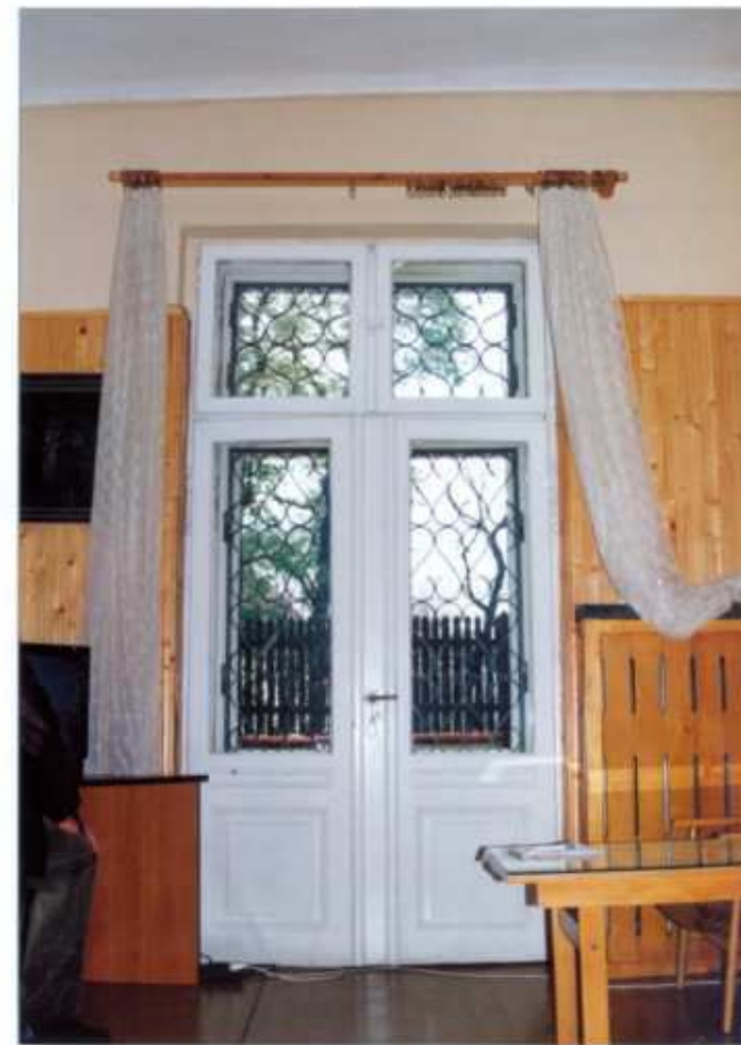
10 - DRZWI NA BALKON OD PÓŁNOCY
